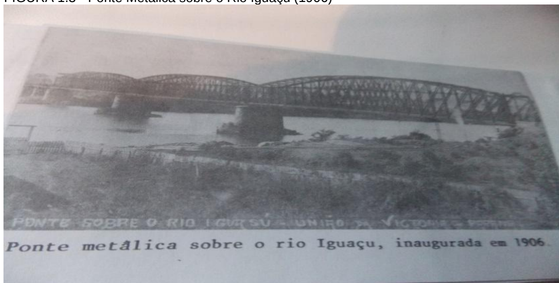
FIGURA 1.3 - Ponte Metálica sobre o Rio Iguaçu (1906)
