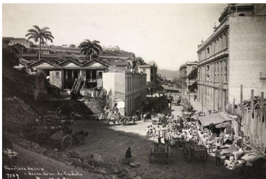
FIGURA 7 – Demolição do Morro do Castelo, abertura de rua paralela à avenida Rio Branco (1929). Autoria: Augusto Malta.
