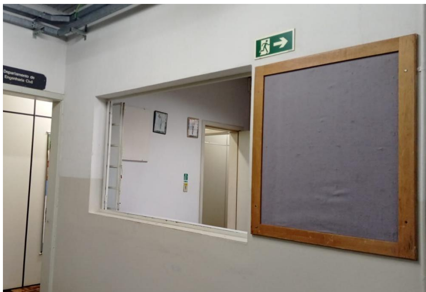
Figura 20 - Placa de sinalização de rota de saída com 2,2 m de altura (Bloco E)
