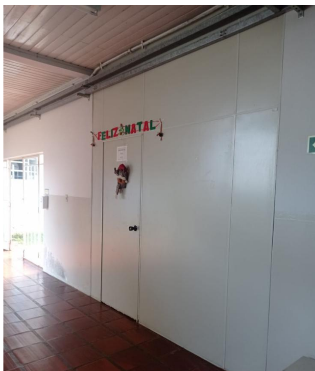
Figura 14 - Paredes de alvenaria e drywall
