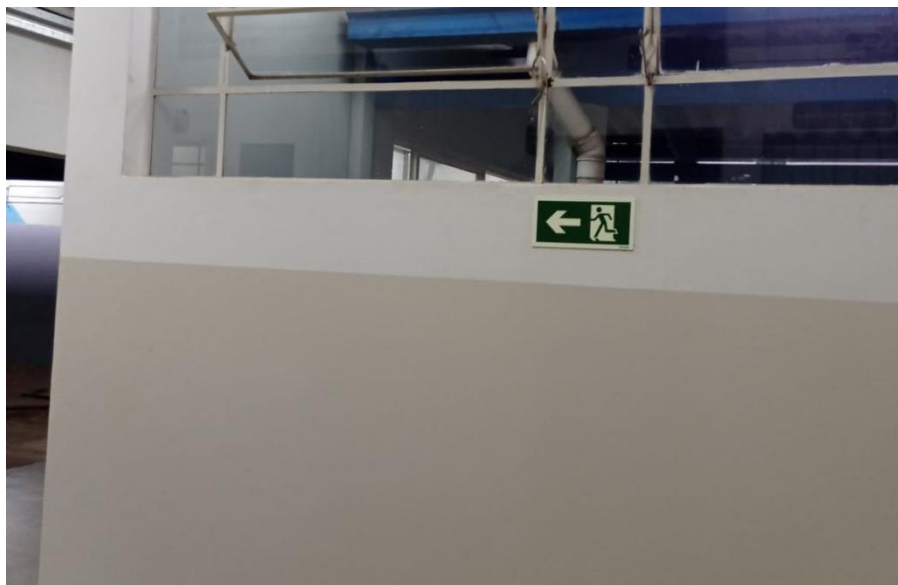
Figura 19 – Placa de sinalização de rota de saída com 1,6 m de altura (Bloco E)
