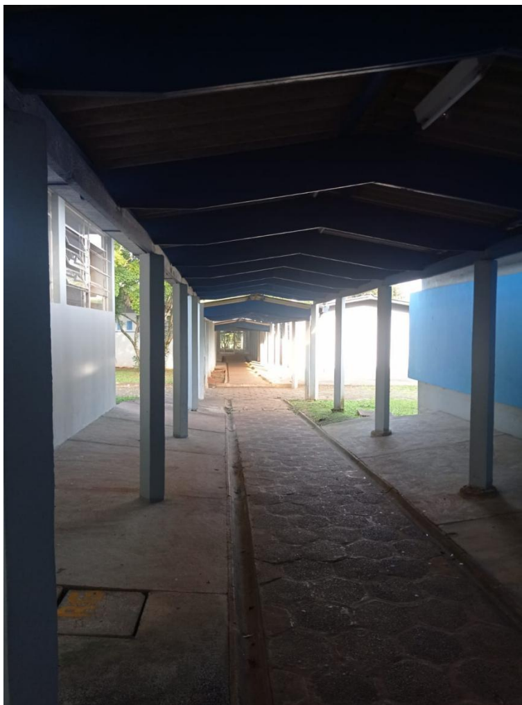
Figura 7 - Passarela coberta ligando blocos
