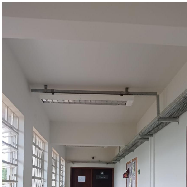
Figura 16 - Forro de gesso
