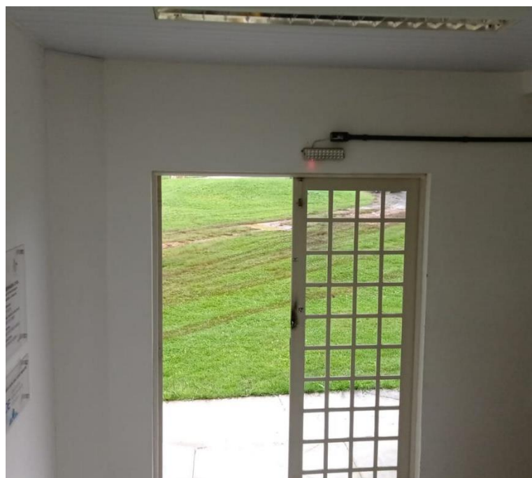
Figura 18 - Luminária de emergência existente
