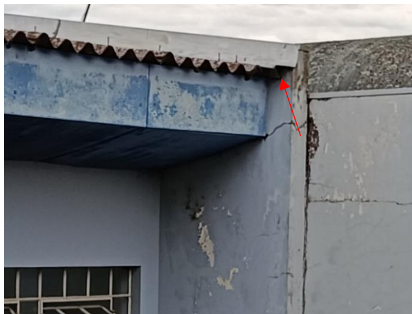
Figura 82: Calha com caimento na alvenaria – Fachada I
