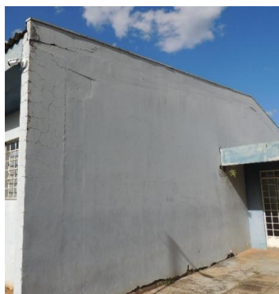
Figura 69: Acesso pela fachada H
