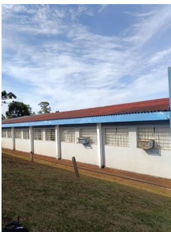
Figura 134: Fachada E – Etapa 2 parte 2
