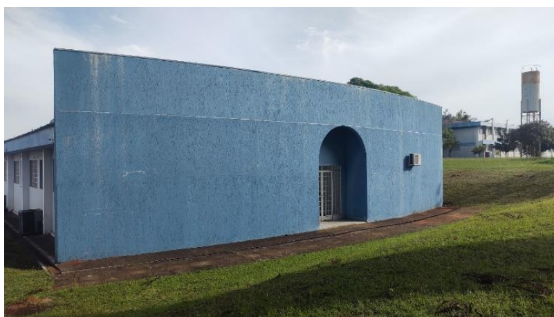
Figura 160: Fachada C – Etapa 2 parte 2
