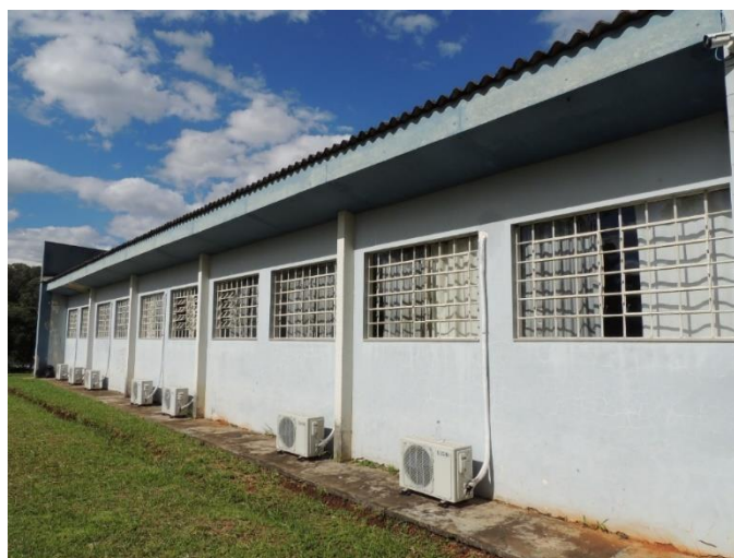
Figura 60: Fachada G da Etapa 1
