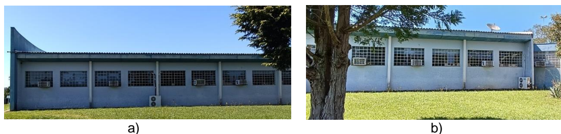
Figura 12: Fachada A – partes a) e b)
