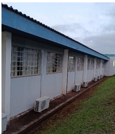
Figura 129: Fachada D – Etapa 2 parte 2
