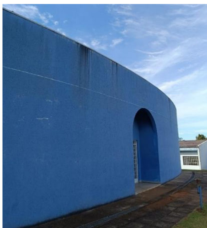
Figura 173: Fachada F – Etapa 2 parte 2
