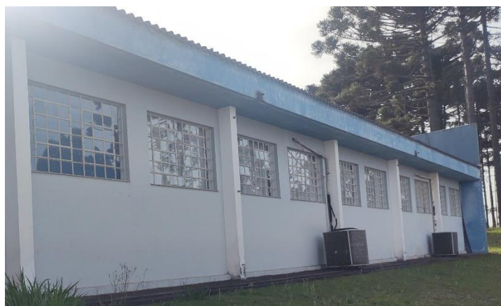
Figura 155: Fachada B – Etapa 2 parte 2
