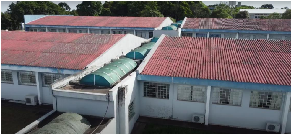
Figura 186: Parte central da cobertura da Etapa 2
