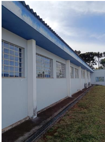
Figura 141: Fachada G – Etapa 2 parte 1
