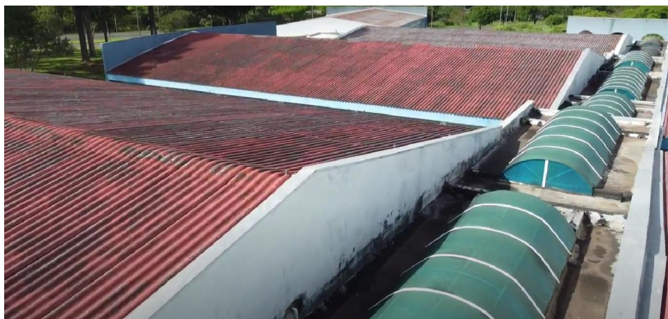
Figura 194: Parte central da cobertura
