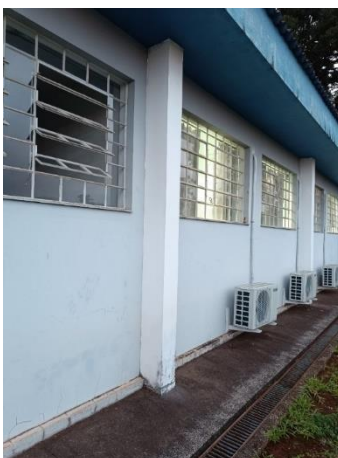
Figura 121: Fachada B – Etapa 2 parte 1
