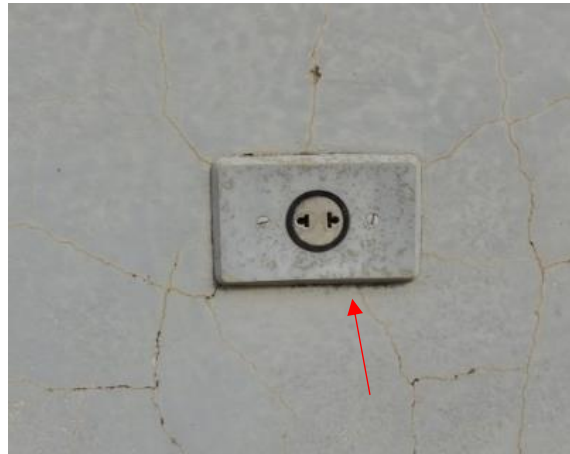
Figura 18: Tomada na fachada A
