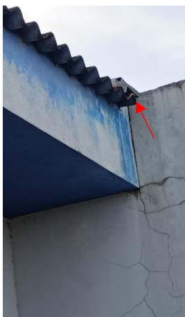
Figura 143: Calha com caimento na alvenaria – Fachada G
