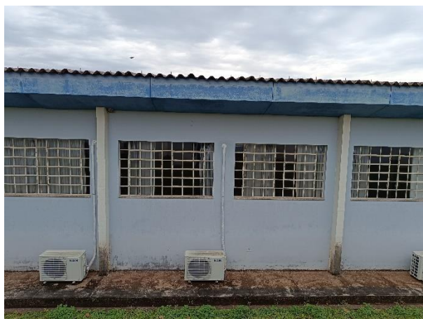
Figura 80: Fachada I da Etapa 1
