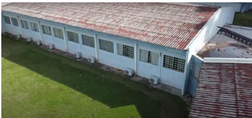
Figura 193: Fachada A e cobertura - Etapa 1
