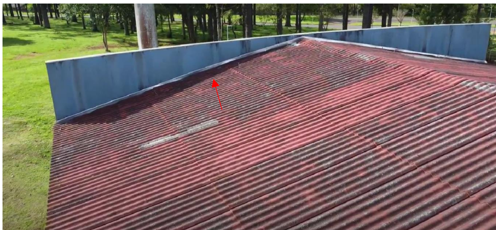
Figura 188: Cobertura da Etapa 2 parte 2 da Central de Salas
