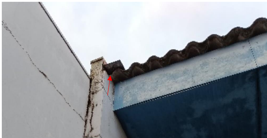
Figura 92: Calha com caimento na alvenaria – Fachada J
