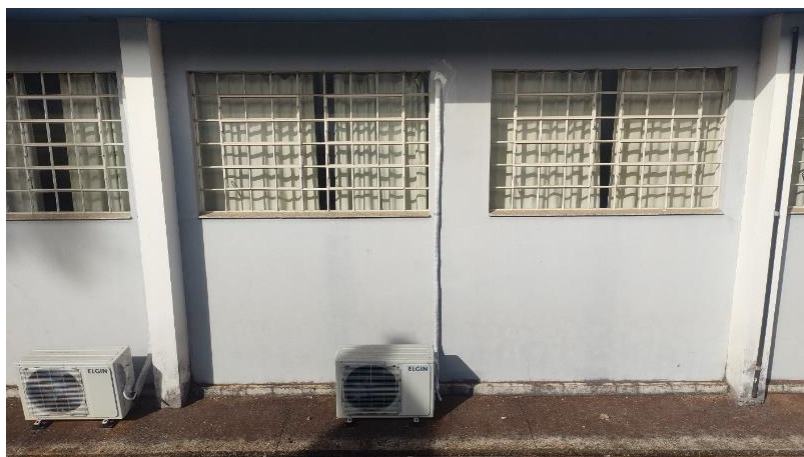
Figura 163: Fachada D – Etapa 2 parte 2
