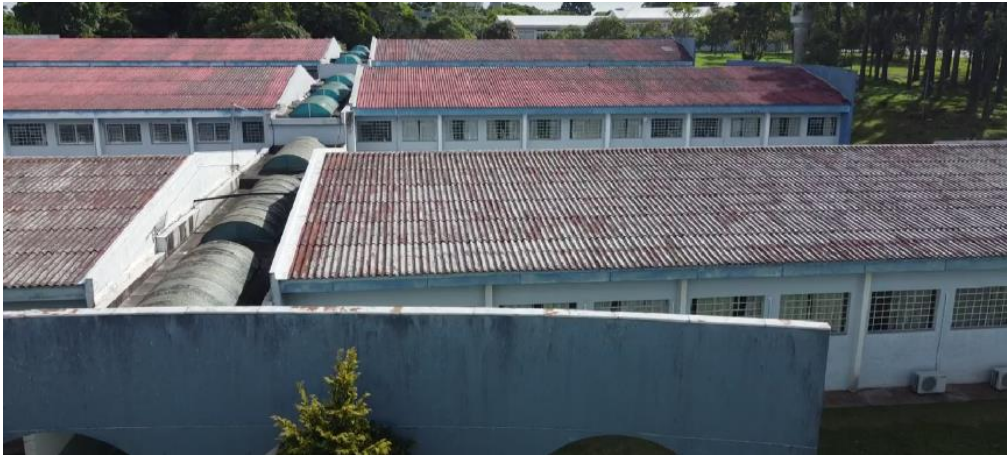
Figura 185: Cobertura - Central de Salas
