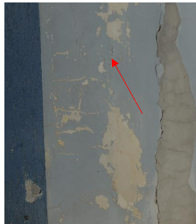
Figura 66: Bolhas no revestimento da fachada G
