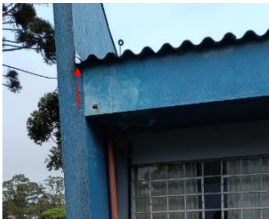
Figura 131: Calha com caimento na alvenaria – Fachada D
