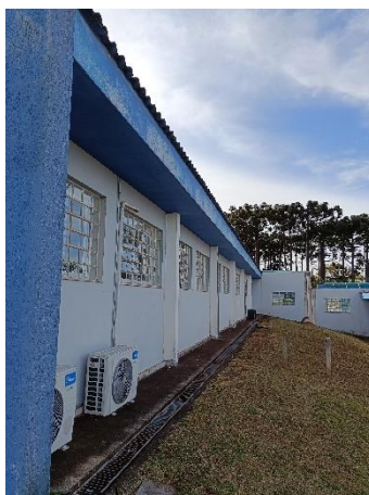
Figura 176: Fachada G – Etapa 2 parte 2
