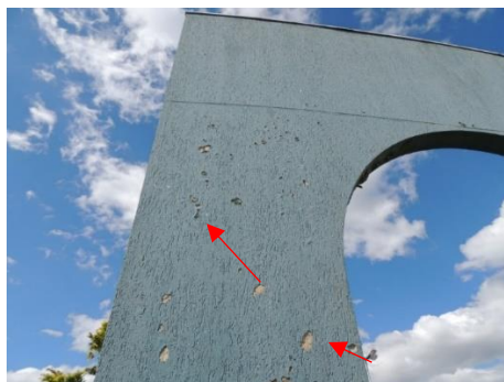
Figura 35: Descamação da textura
