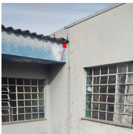
Figura 165: Calha com caimento na alvenaria - Fachada D
