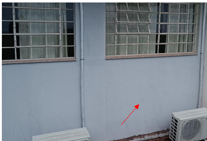
Figura 132: Fissuras mapeadas – Fachada D
