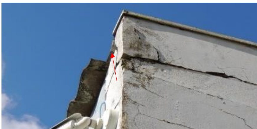
Figura 74: Calha com caimento na alvenaria – Fachada H
