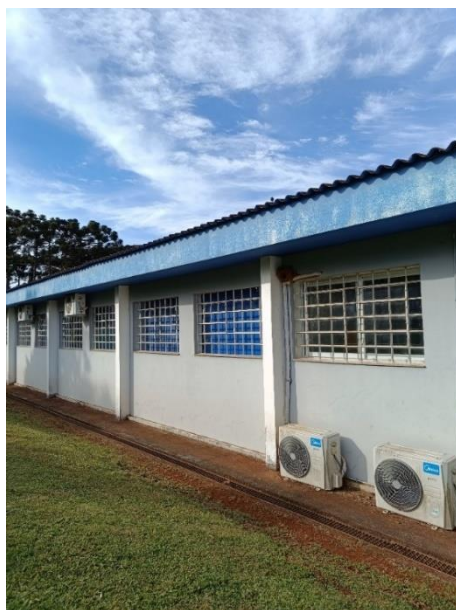
Figura 167: Fachada E – Etapa 2 parte 2
