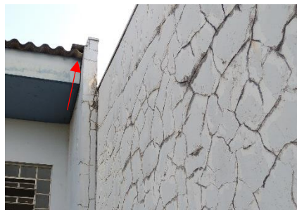
Figura 26: Calha da cobertura na fachada B
