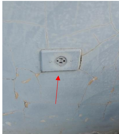
Figura 40: Tomada na fachada D
