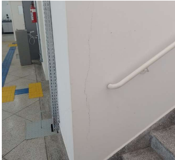
Figura 33 - Fissura vertical
