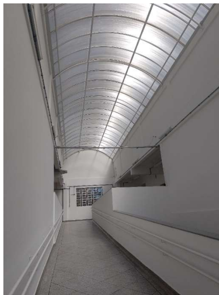
Figura 17 - Cobertura da rampa
