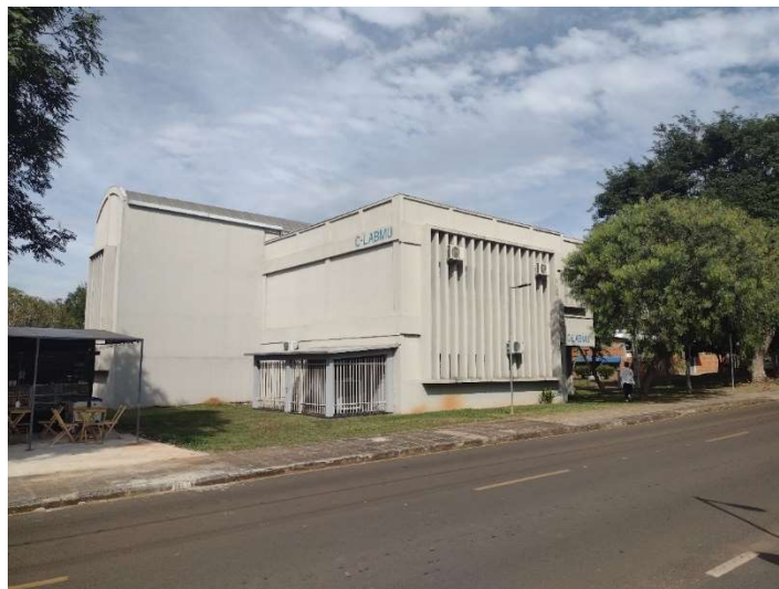
Figura 25 - Fachada e lateral esquerda
