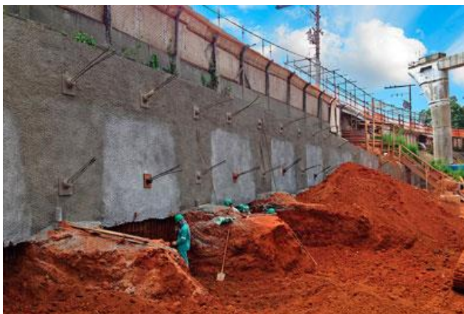
Figura 15 - Tirantes durante processo de execução de contenção em cortina atirantada
