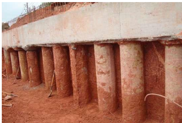
Figura 12 - Cortina com estacas
