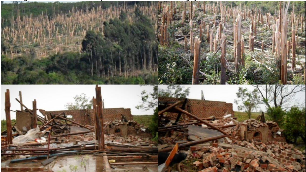
Figura 19 - Danos causado por um tornado EF2 em Canguçu-RS, em 03 de maio de 2013.
