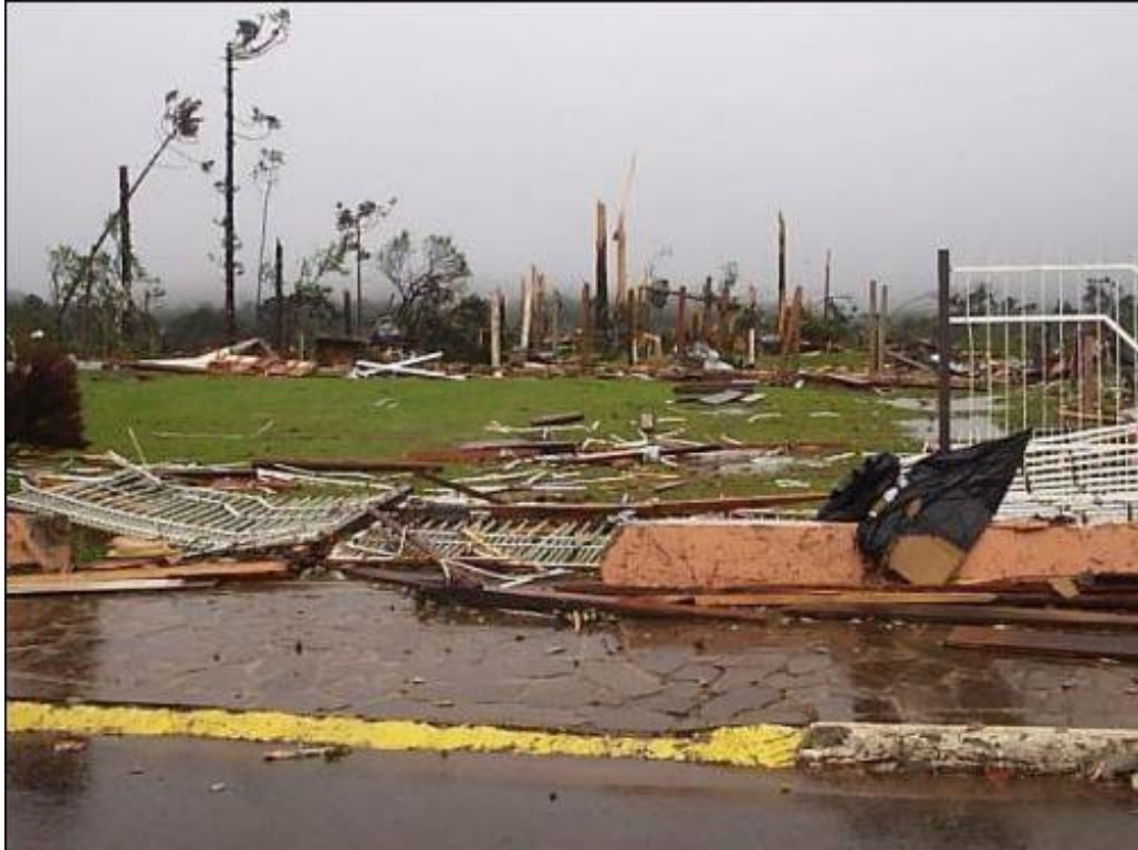
Figura 23 - Árvores destruídas pela força dos ventos. Tornado de Muitos Capões-RS
