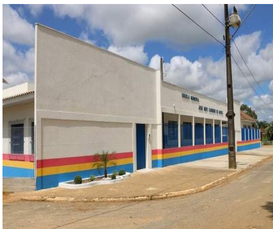
FIGURA 4: ESCOLA MUNICIPAL DO CAMPO JOSÉ NERY CARNEIRO DE NAPOLI
