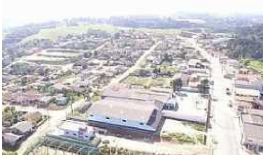
FIGURA 1:IMAGENS DA LOCALIDADE DE SOCAVÃO DISTRITO DE CASTRO-PR
