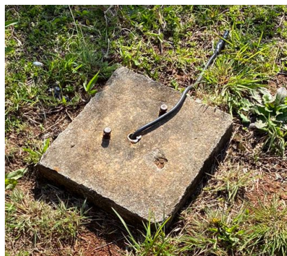
Figura 28 – Espera para instalação de poste de luz no estacionamento
