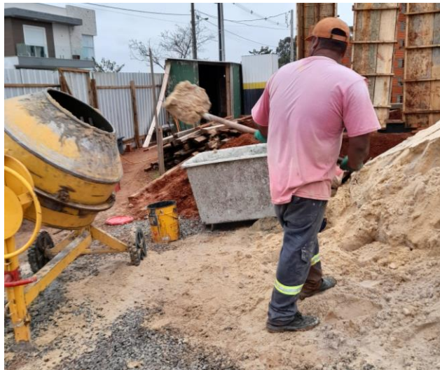
Figura 15 - Adição de agregado miúdo com pá - Obra 05.
