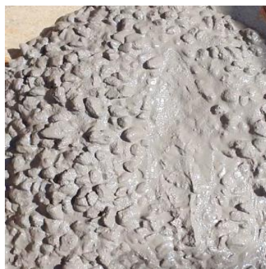
Figura 19 - Análise visual do concreto da obra 06.
