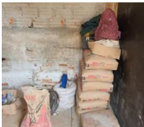
Figura 13 - Sacos de cimento armazenados próximos a parede de alvenaria.
