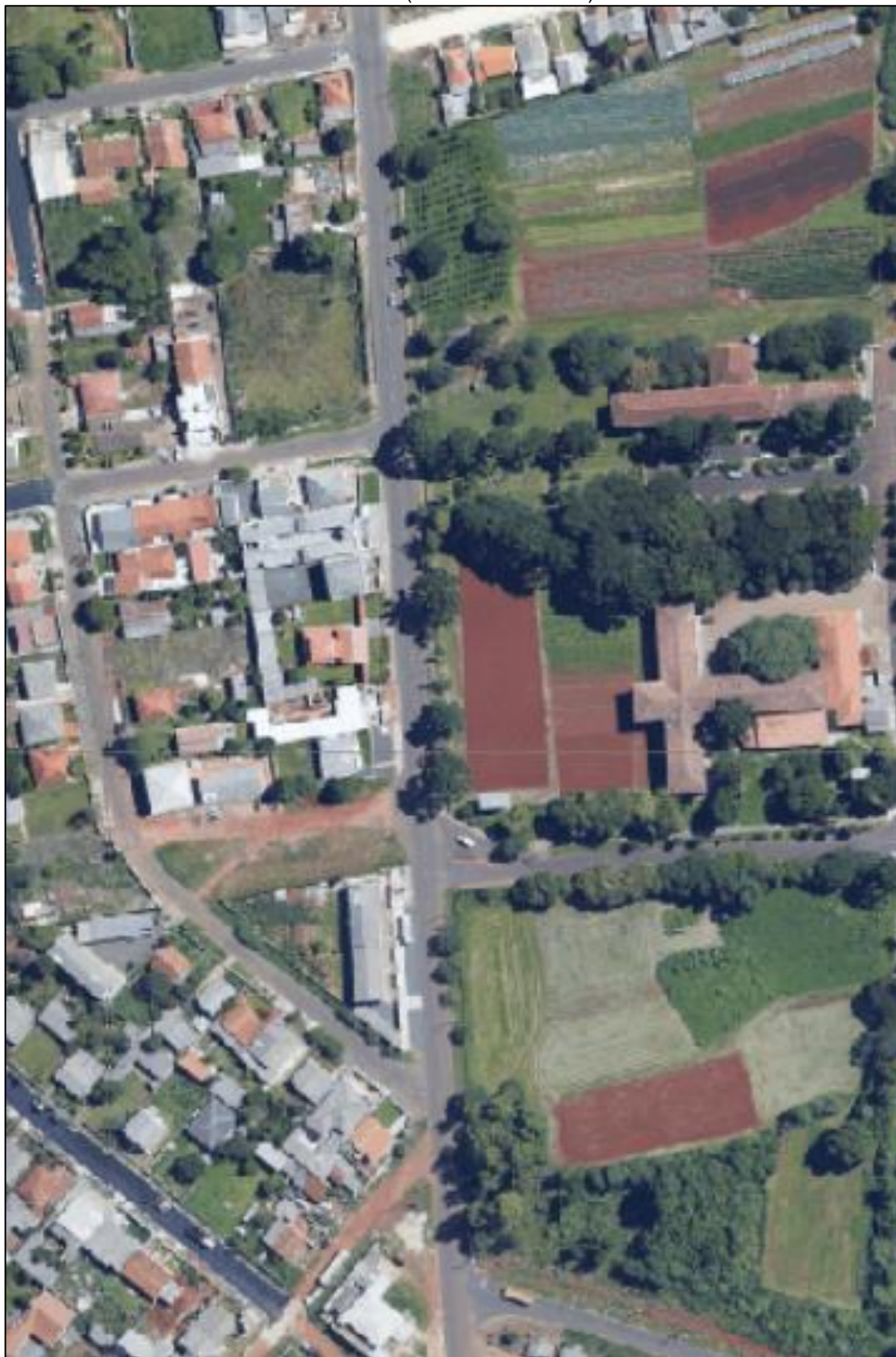
FIGURA 114 – ORTOFOTO DE 2015: SEGUNDA QUADRA DA RUA ALAMEDA NABUCO DE ARAÚJO (OCORRÊNCIA 08)
