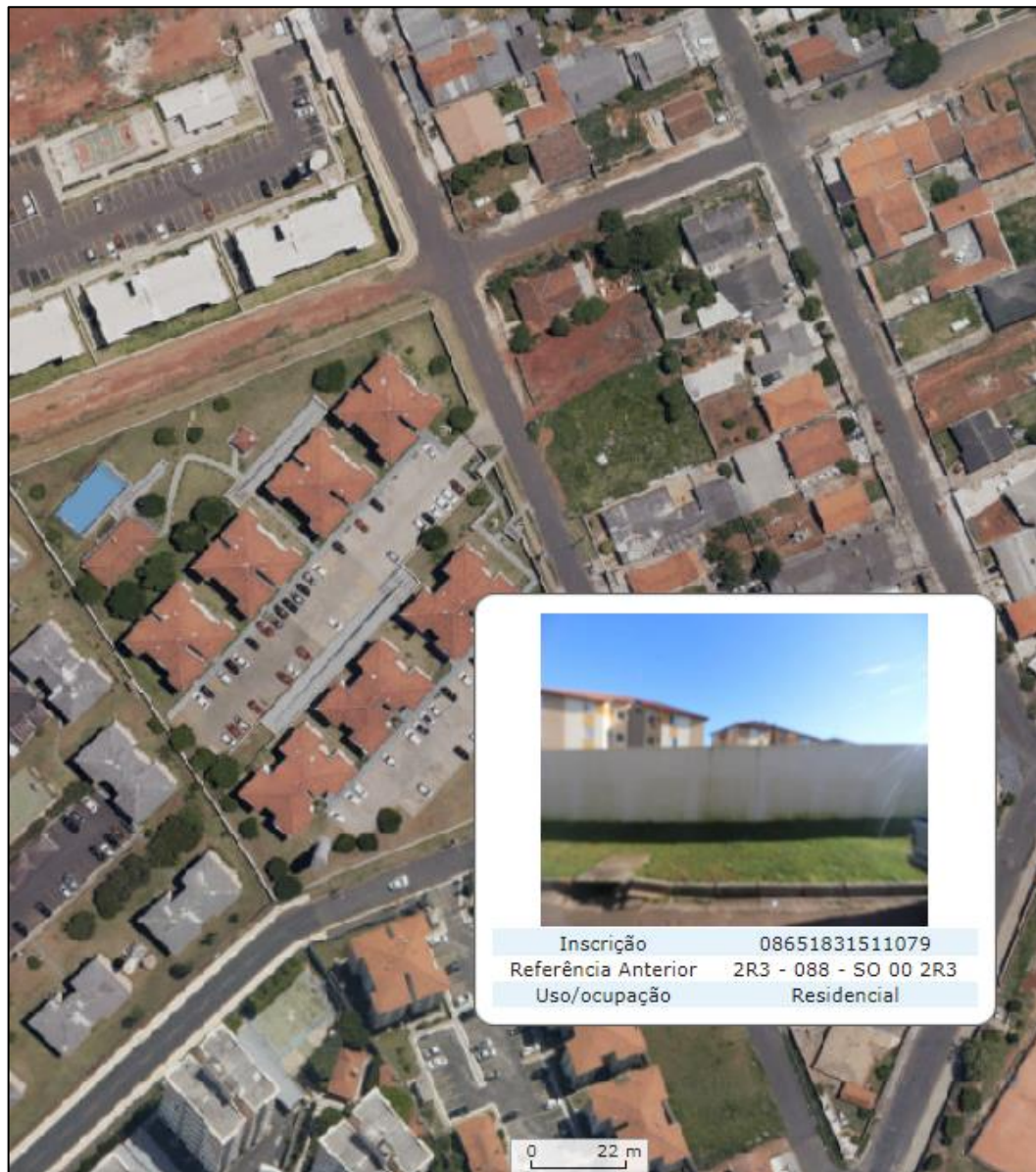
FIGURA 14 - UMA DAS EDIFICAÇÕES DA RUA LEOPOLDO MIQUES, LOCALIZAÇÃO DA 2ª OCORRÊNCIA LISTADA
