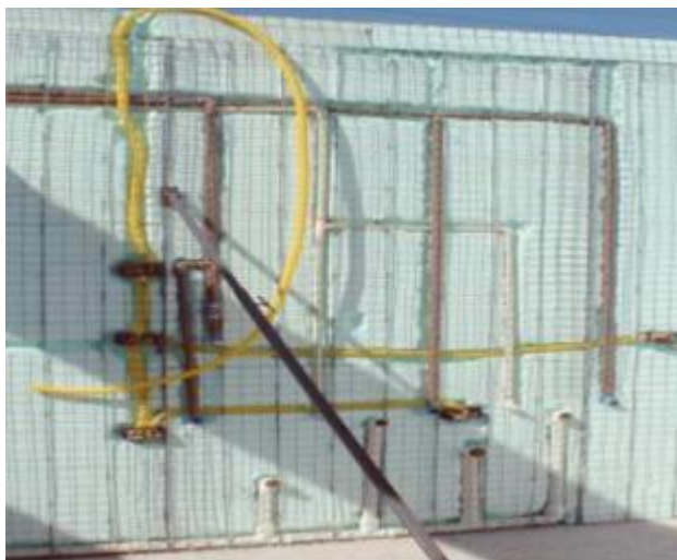
Figura 17 - Instalações hidráulicas no sistema Monolite
