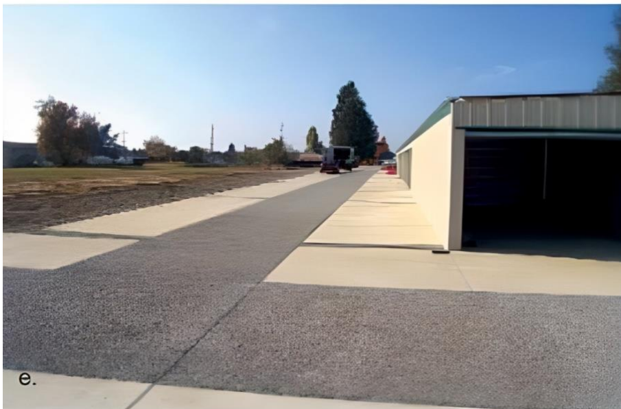
Figura 2 – Pavimento permeável aplicado em calçadas
