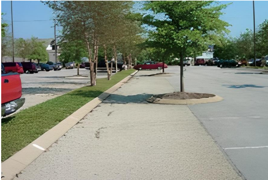
Figura 1 – Pavimento permeável aplicado em estacionamento
