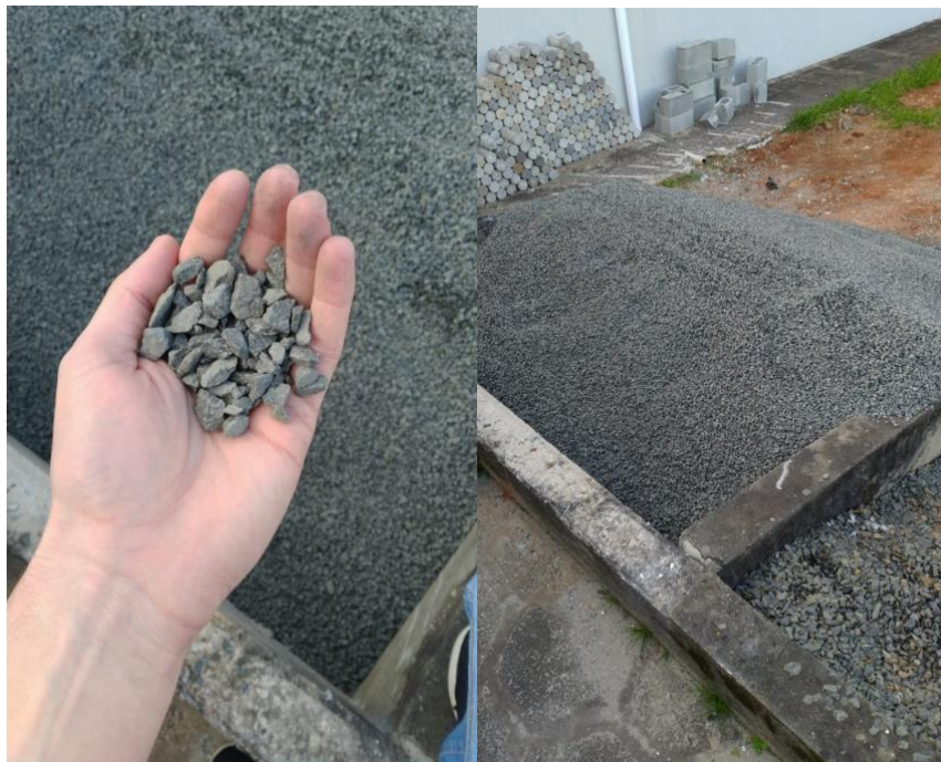
Figura 11 – Agregado graúdo utilizado na confecção do concreto
