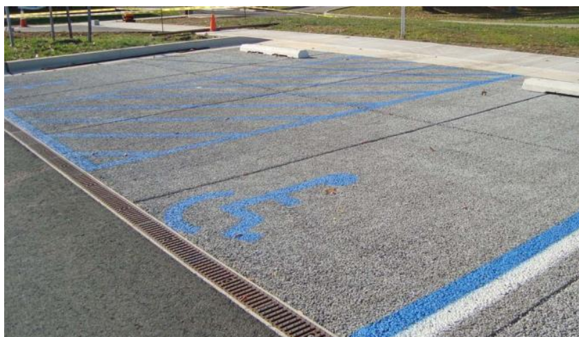
Figura 6 - Concreto permeável moldado in loco
