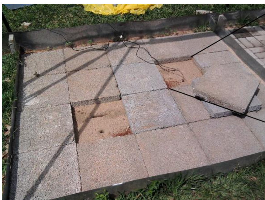
Figura 5 - Placas de concreto permeável
