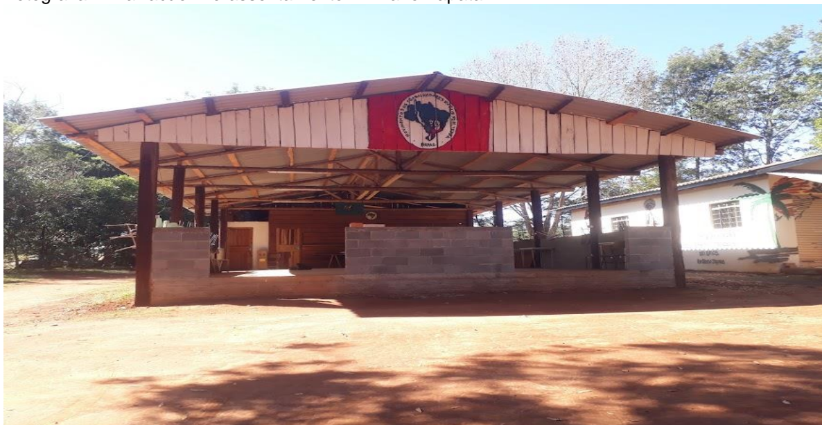
Fotografia 2: Barracão Pré-assentamento Emiliano Zapata
