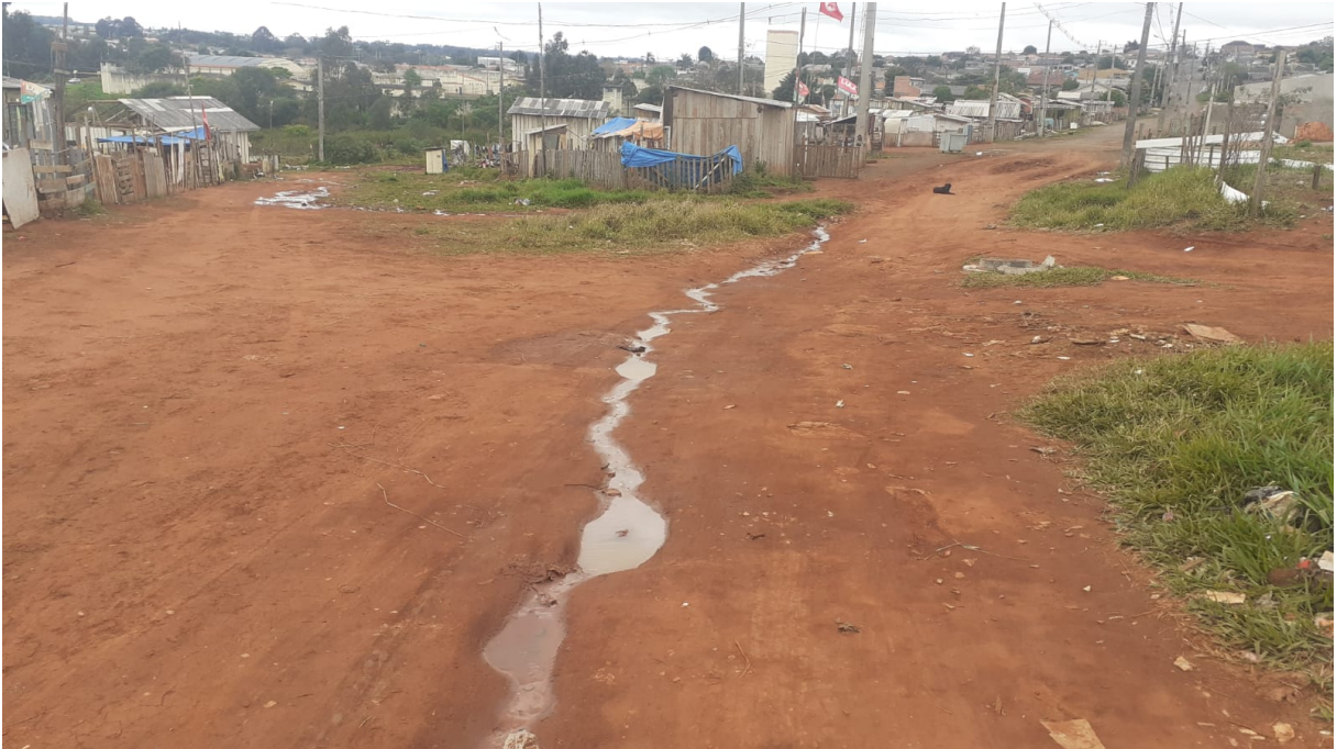
Figura 6 - Esgoto a céu aberto
