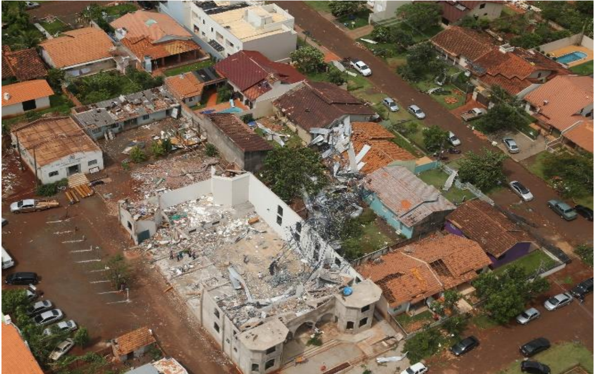
Figura 8 - Destruição decorrente de um tornado múltiplos vórtices em Marechal Cândido Rondon no ano de 2015
