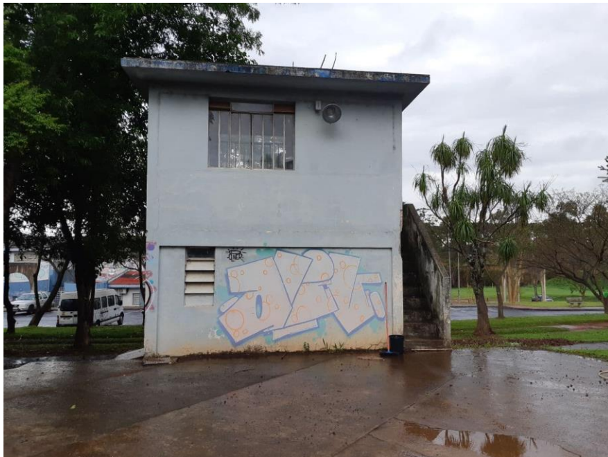
Figura 36 - Depósito de materiais de TI
