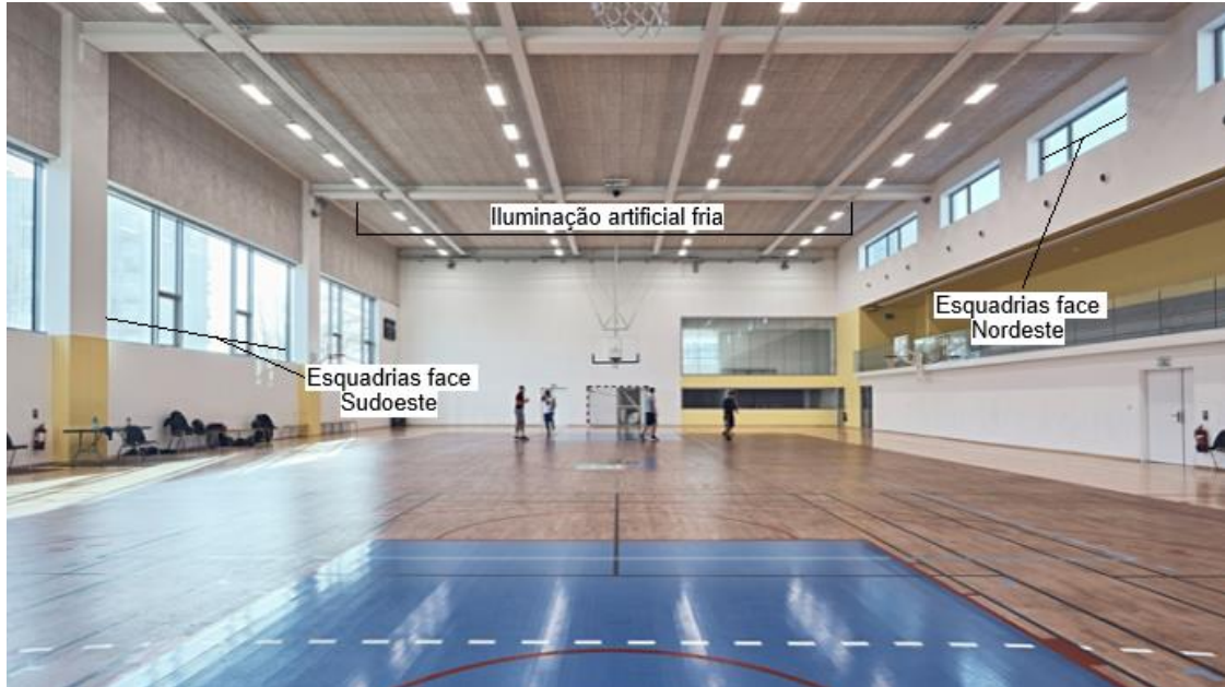
Figura 12 – Esquadrias da quadra do Ginásio
