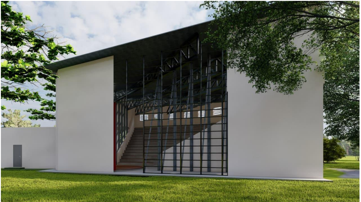
Figura 58 – Parede metálica
