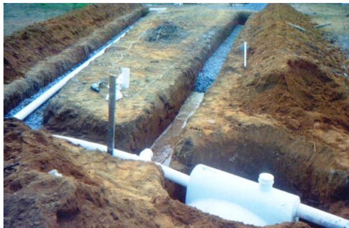
Figura 13 – Sistema de infiltração no solo
