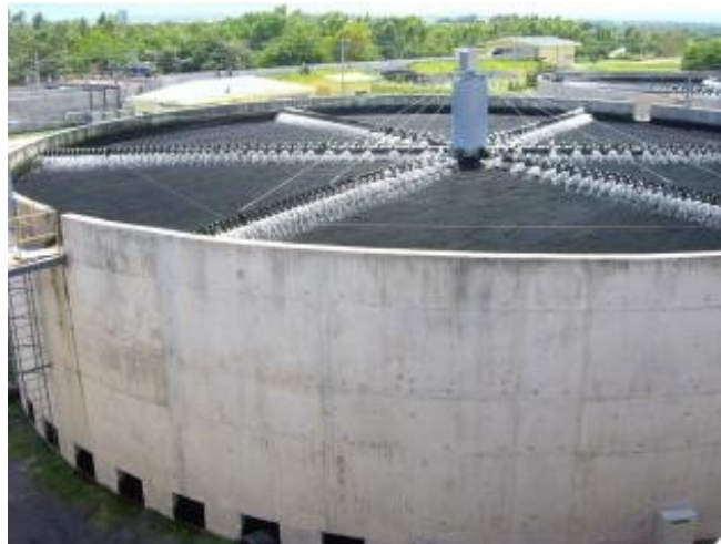
Figura 8 – Filtro biológico por gotejamento ( trickling filter )
