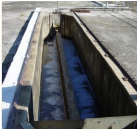
Figura 3 – Desarenador de fluxo horizontal
