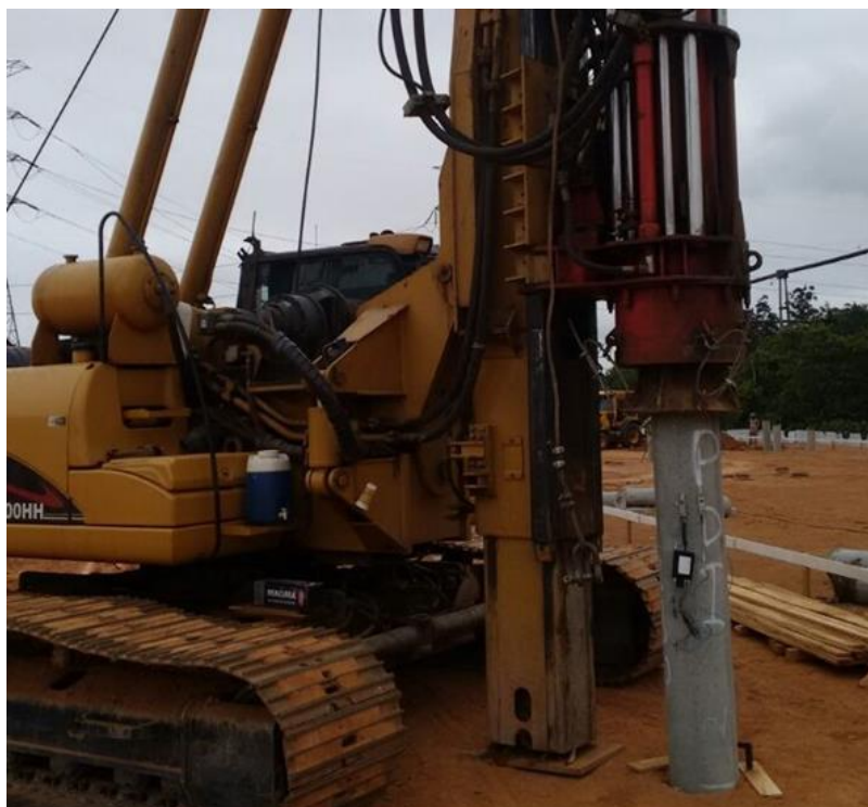
Figura 11- Execução de ECD
