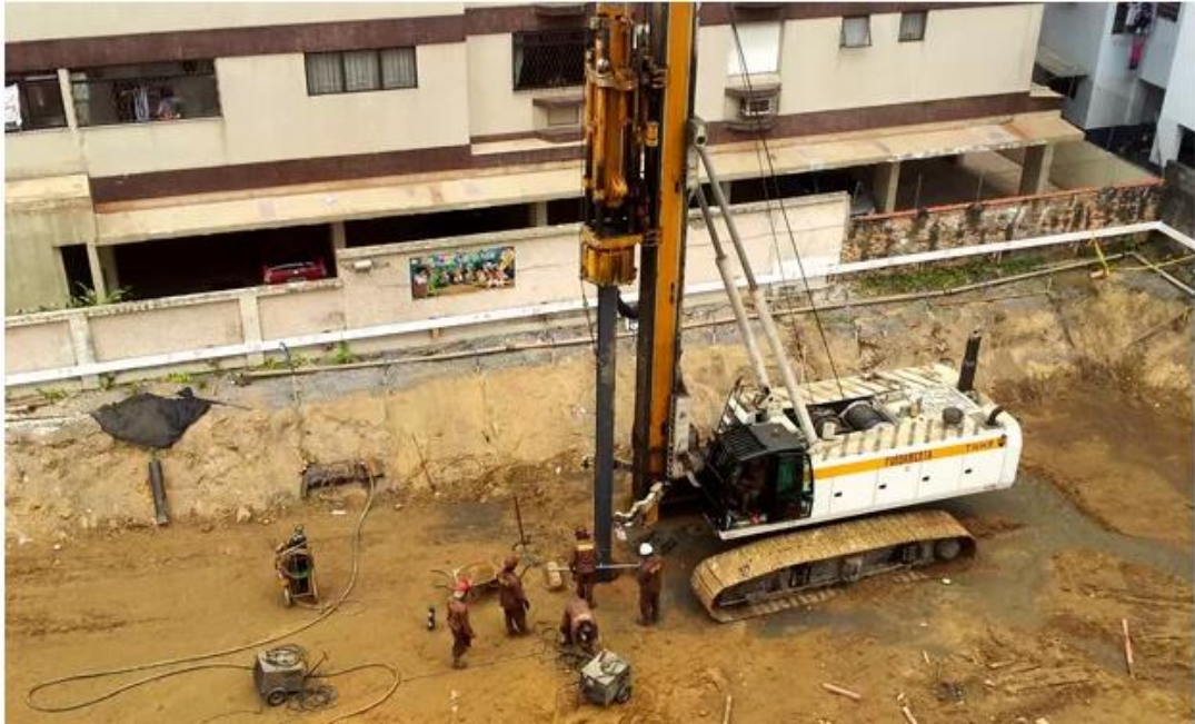
Figura 2- Bate- estacas
