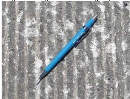
Figura 3 – Rugosidade na fresagem padrão
