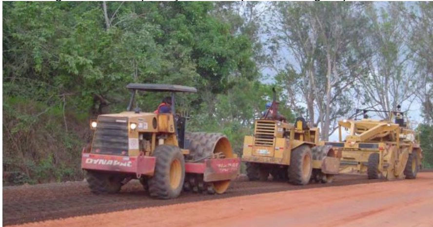
Figura 23 – Compactação inicial após a reciclagem profunda
