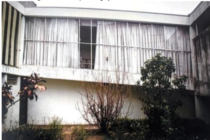
Figura 18 – Rampa de ligação da Casa Lauro Justus
