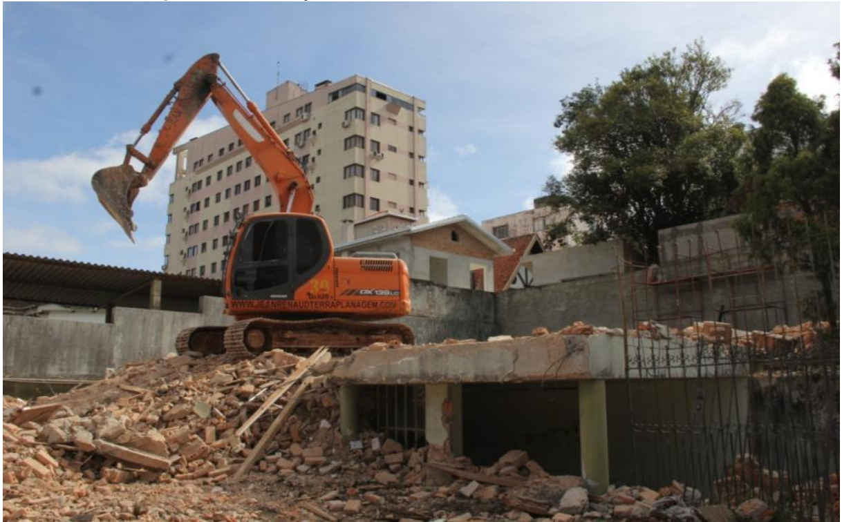
Figura 28 – Demolição da Casa Lauro Justus em Ponta Grossa/PR
