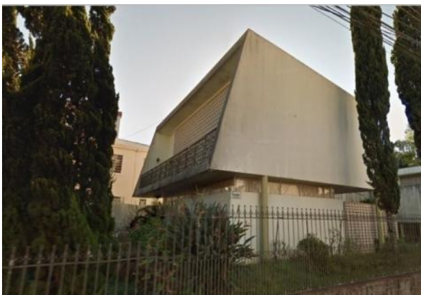
Fotografia da Casa Lauro Justus no contexto da discussão sobre seu tombamento pelo COMPAC. O projeto é do arquiteto Miguel Juliano. No ano de 2019 chegou a ser tombada preliminarmente, mas acabou excluída no mesmo processo da Casa Correia de Sá. Fonte: Acervo Diário dos Campos (2022).
