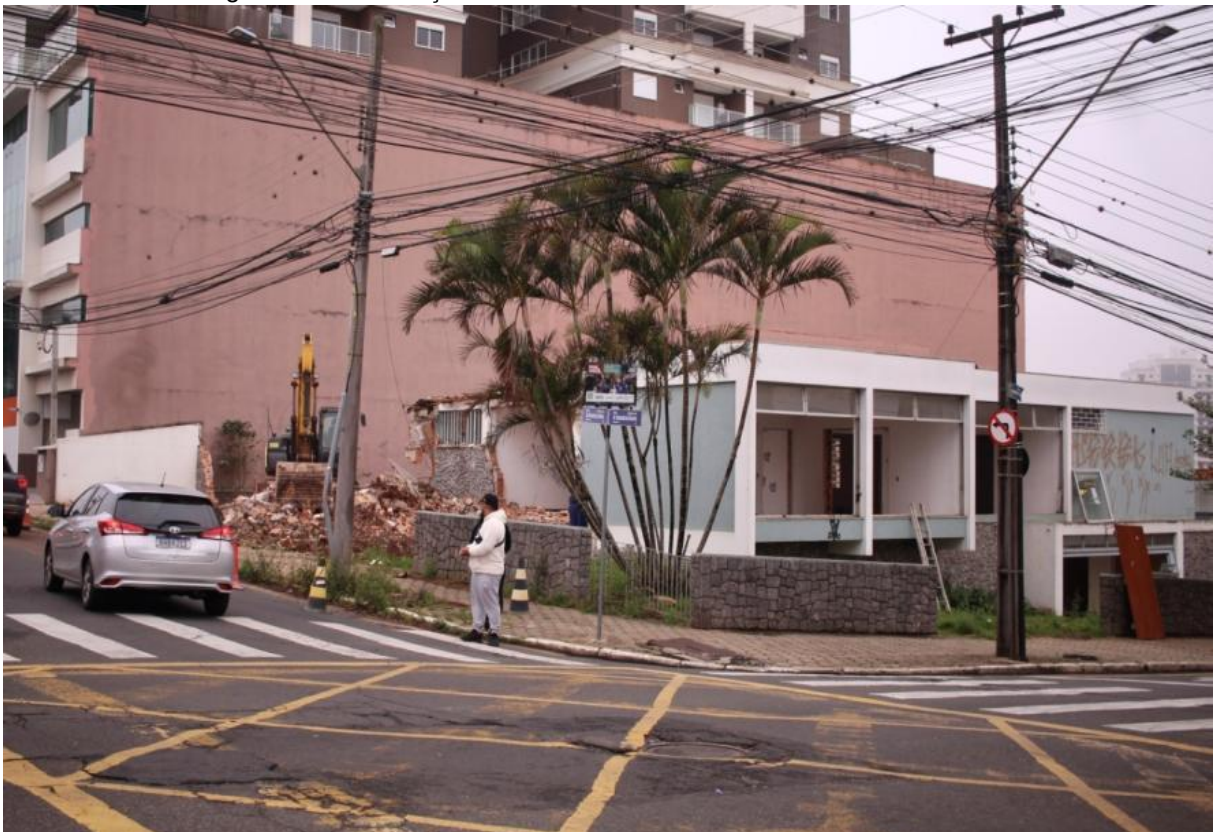
Figura 33 – Demolição da Casa Família Ribas em Ponta Grossa/PR
