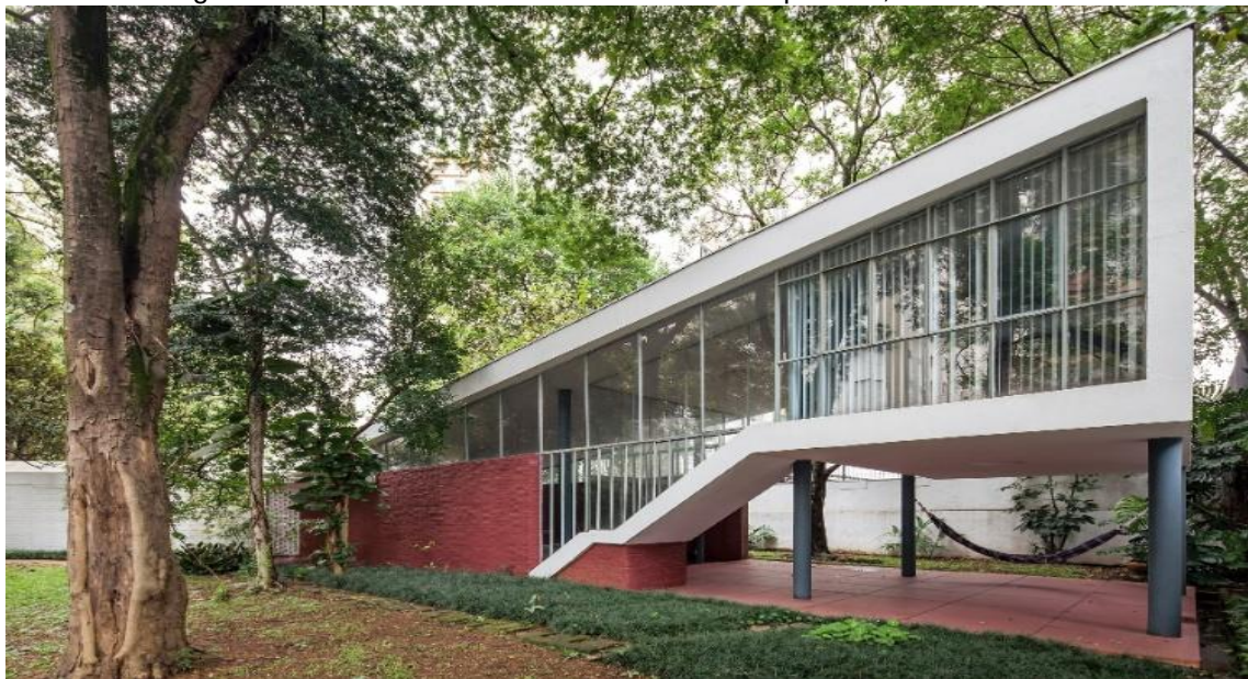
Figura 10 – Fachada da casa no bairro de Campo Belo, São Paulo/SP
