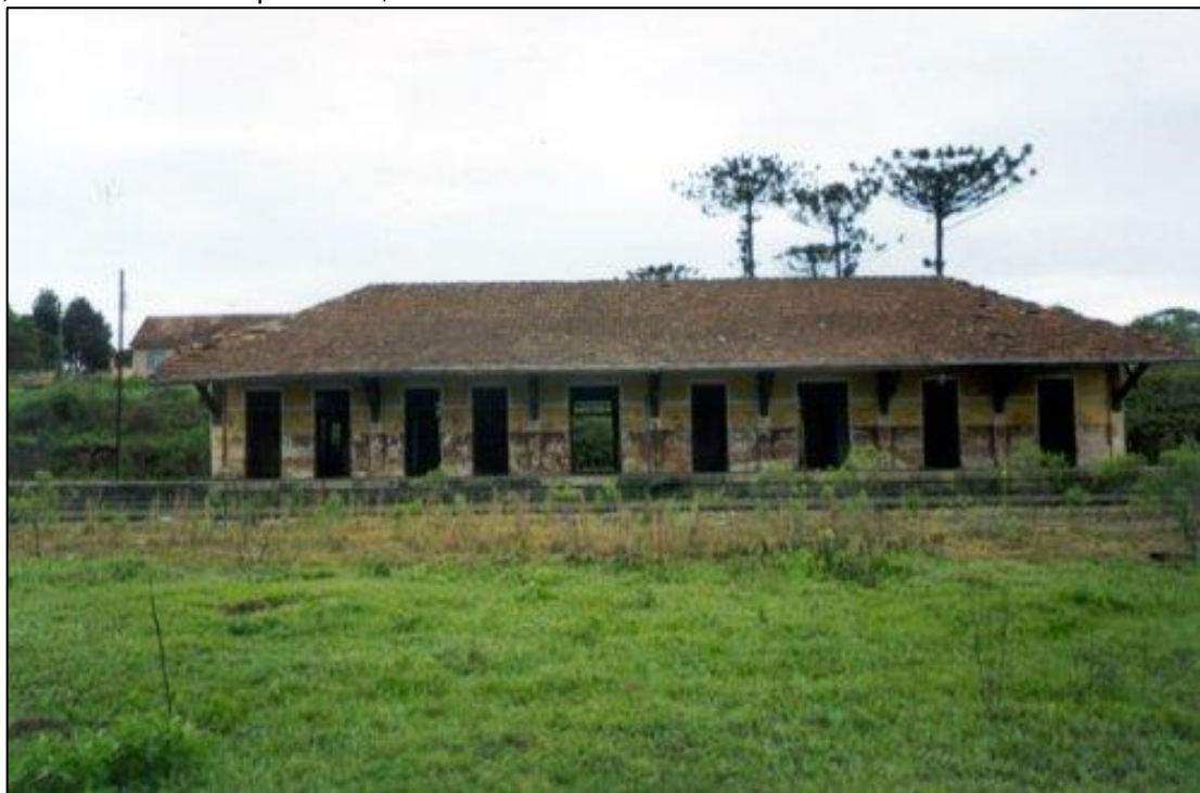
Figura 28 - Antiga estação ferroviária de Engenheiro Gutierrez, instalada sobre folhelhos da Formação Irati, foi o local descrito por White, em 1906.
