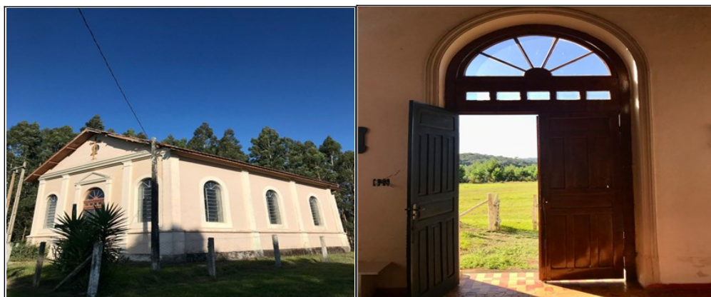
Figura 11 – Aspectos do externo e da parte interna da Capela do Bairro Água Branca
