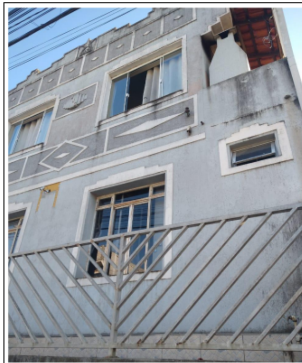
Figura 03 – Edificação em bom estado em Cerro Azul – Paraná
