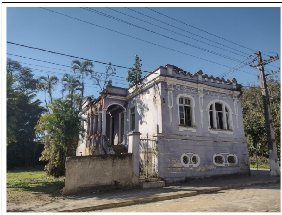
Figura 01 – Edificação deteriorada em Cerro Azul – Paraná
