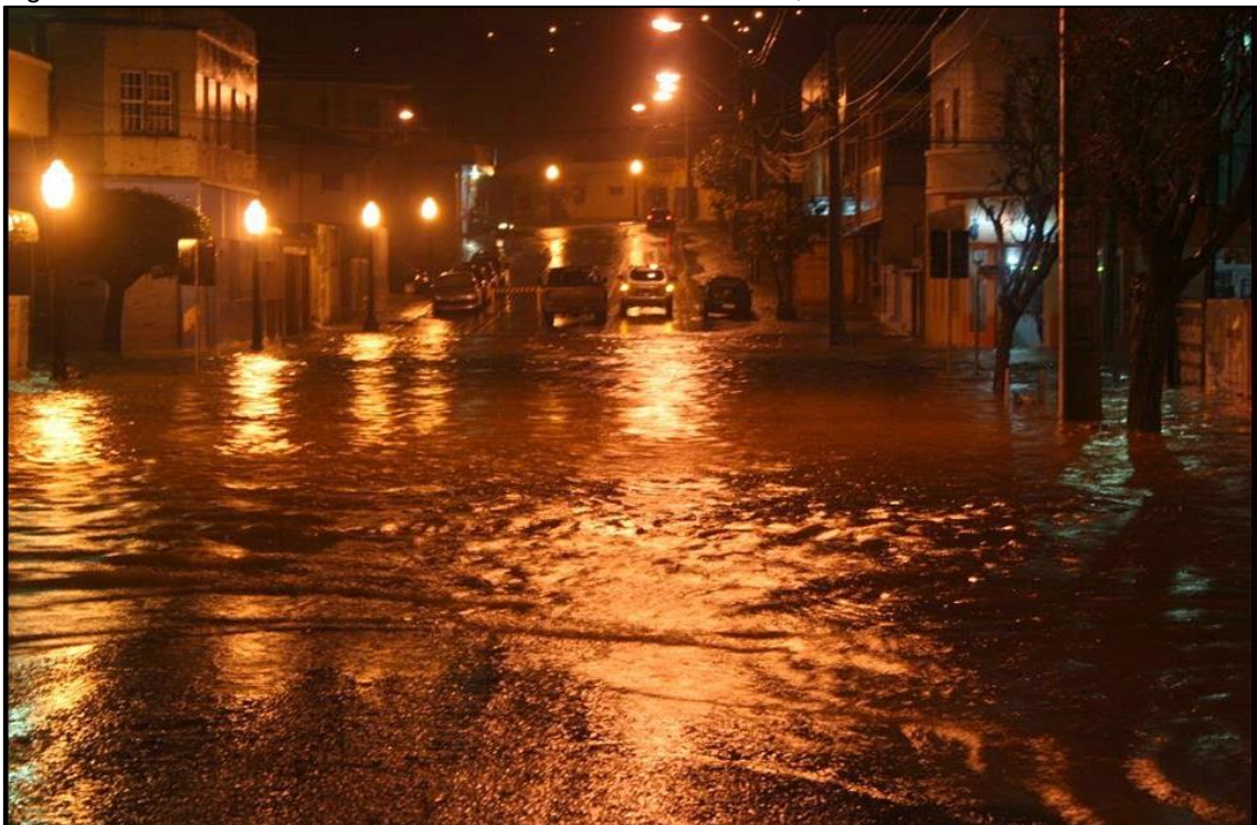
Figura 22 – Extravasamento do Arroio dos Pereiras em 2014, Irati-PR
