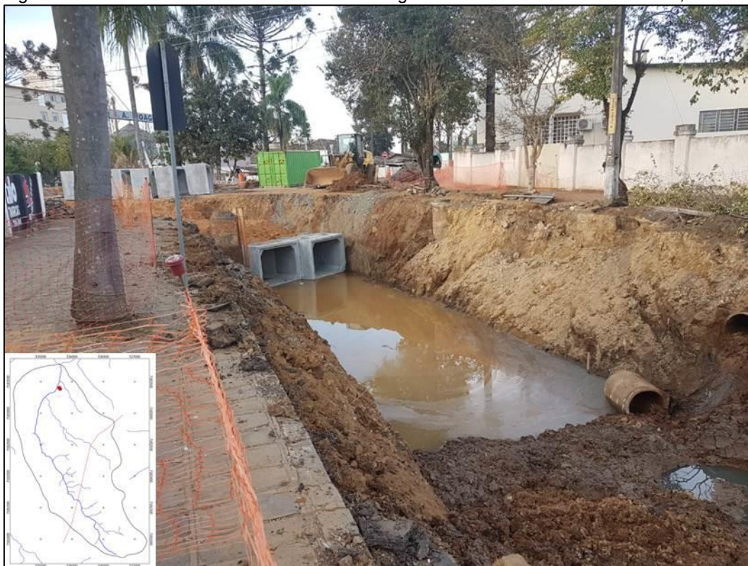
Figura 42 – Obra de melhoria da rede de drenagem na Bacia Arroio dos Pereiras, Irati-PR
