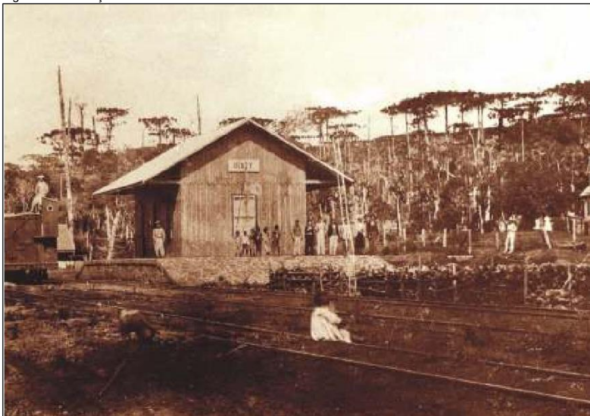
Figura 14 – Estação Ferroviária em 1899 – Irati-PR
