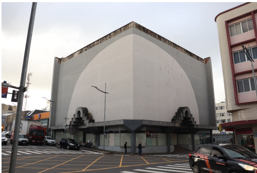
FOTOGRAFIA 33 – Local da sede do Jornal da Manhã, na esquina das ruas Balduino Taques e Comendador Miró. O prédio foi demolido, dando lugar ao que aparece na foto..
