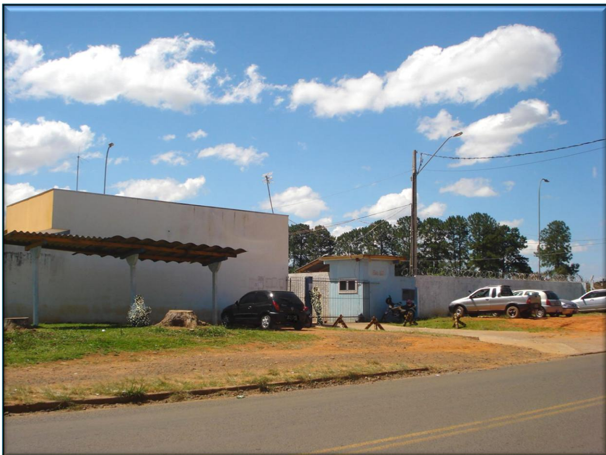
Figura 01: Fachada do Mini – Presídio Hildebrando de Souza na cidade de Ponta Grossa, Paraná.
