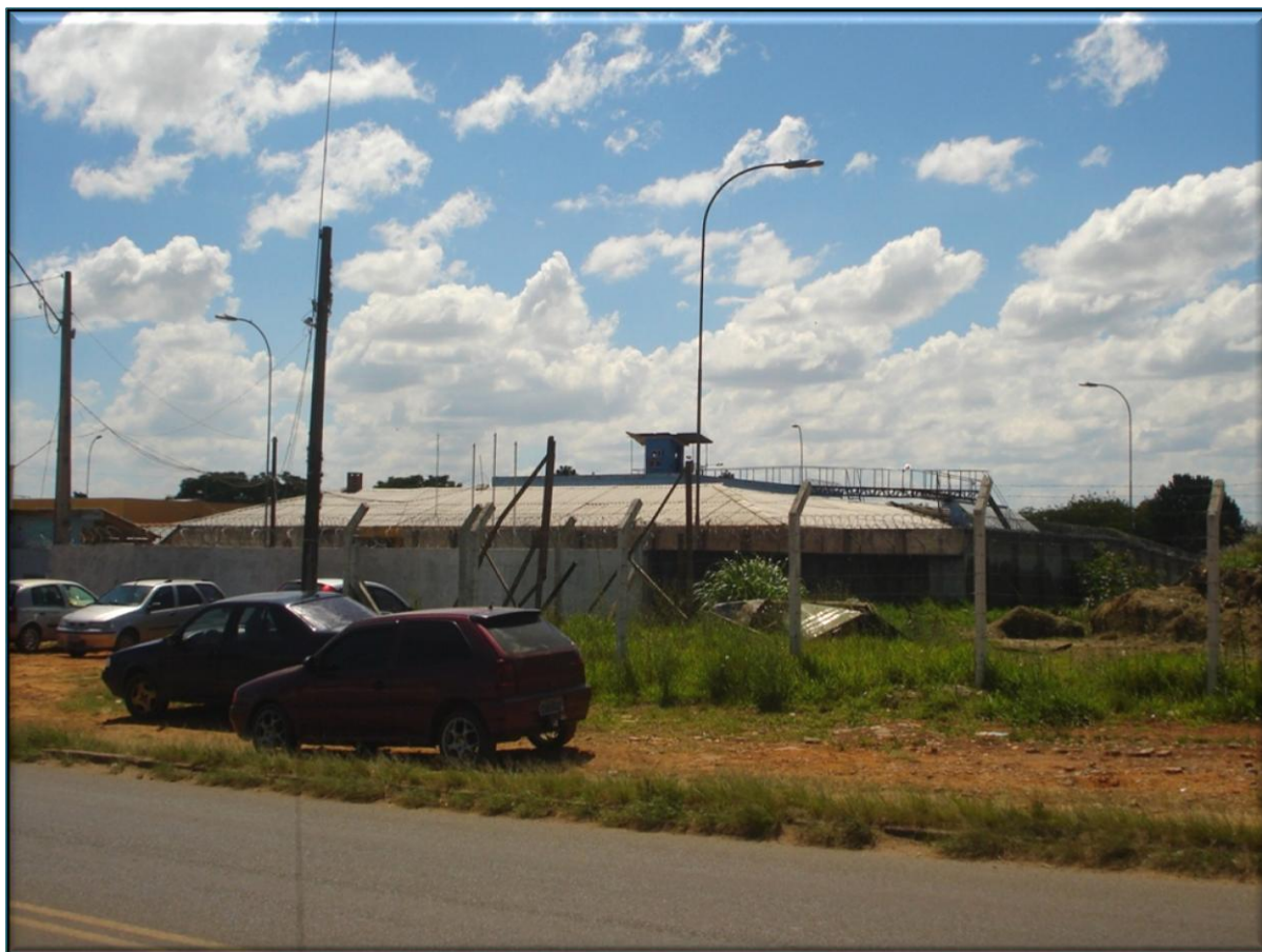
Figura 02: Vista Lateral esquerda do Mini – Presídio Hildebrando de Souza na cidade de Ponta Grossa, Paraná
