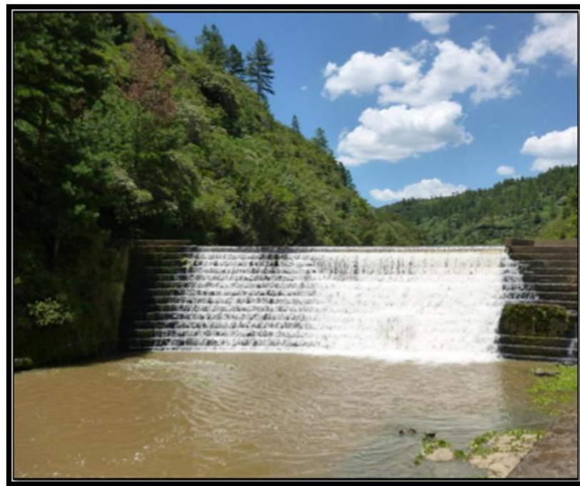
Figura 14. Barragem construída utilizando-se das paredes abruptas do canyon do rio Jaguariaíva para a produção de energia hidroelétrica. Fonte: Corrêa (2014).
