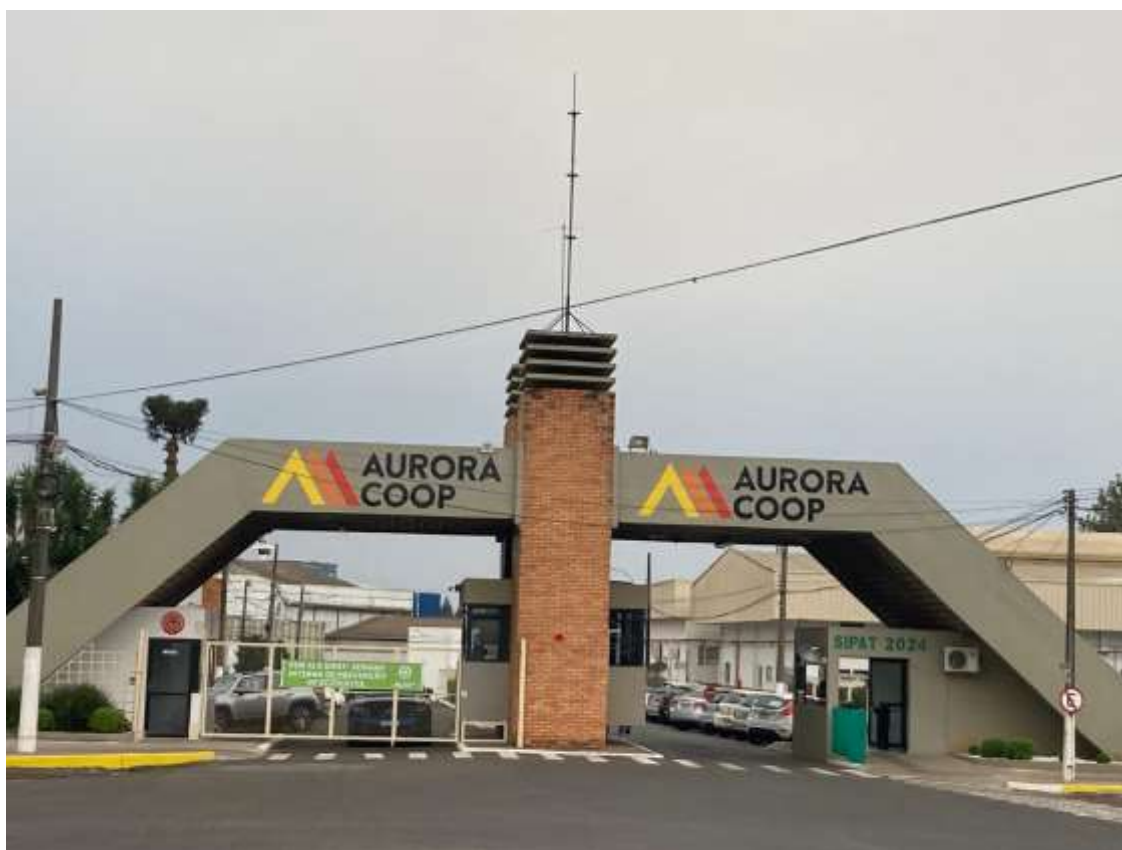
Figura 23 - Unidade da Aurora Coop em Chapecó.
