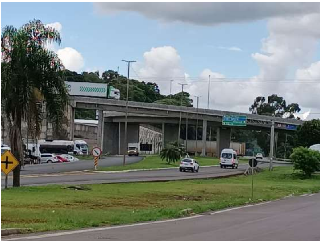
Figura 49 - Rodovia BR 282, entroncamento com a BR 480 na cidade de Chapecó/SC.
