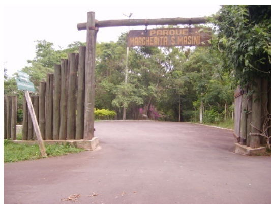
Foto 31. Parque Marguerita Masini.(entrada abandonada). Fonte: VILELA, 2007.
