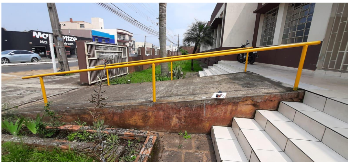
Figura 25 - Rampa principal 1 existente
