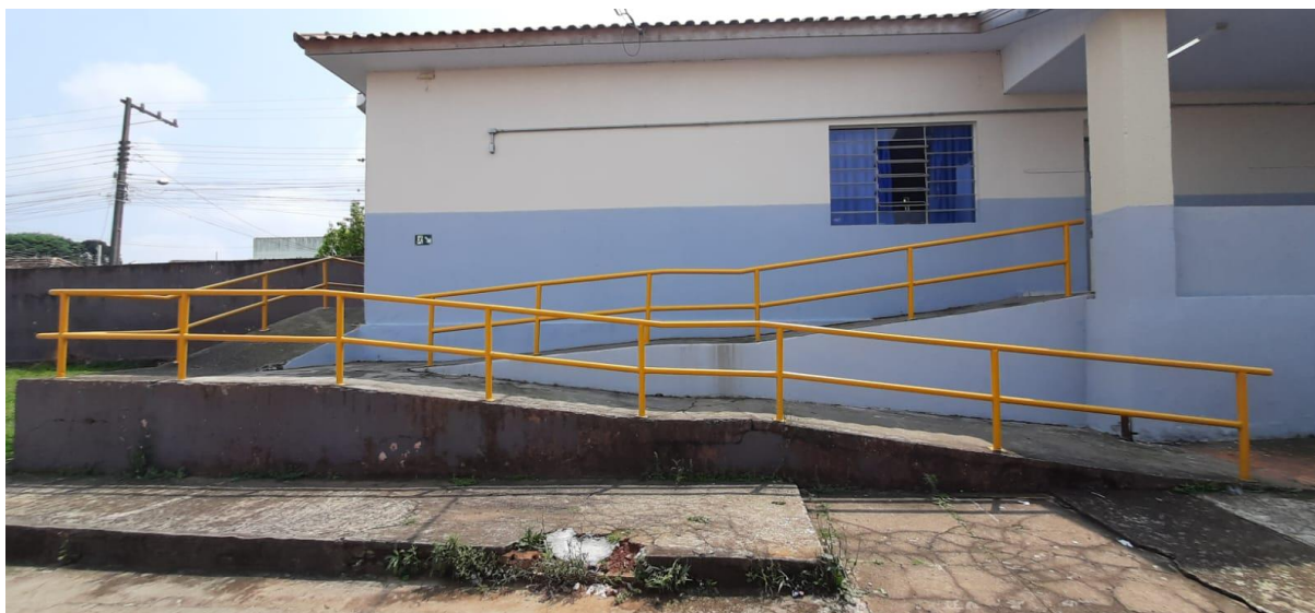
Figura 36 - Rampa principal 4 existente
