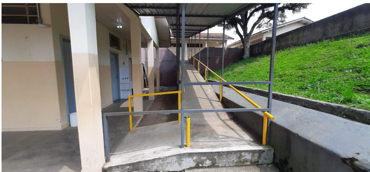
Figura 33 - Rampa principal 3 existente
