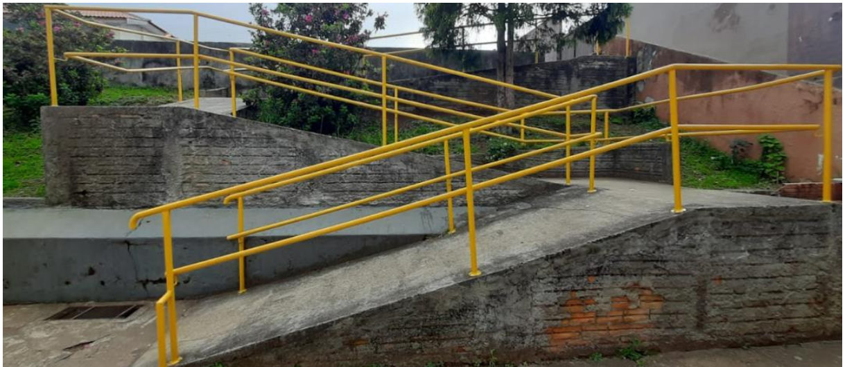
Figura 39 - Rampa principal 5 existente
