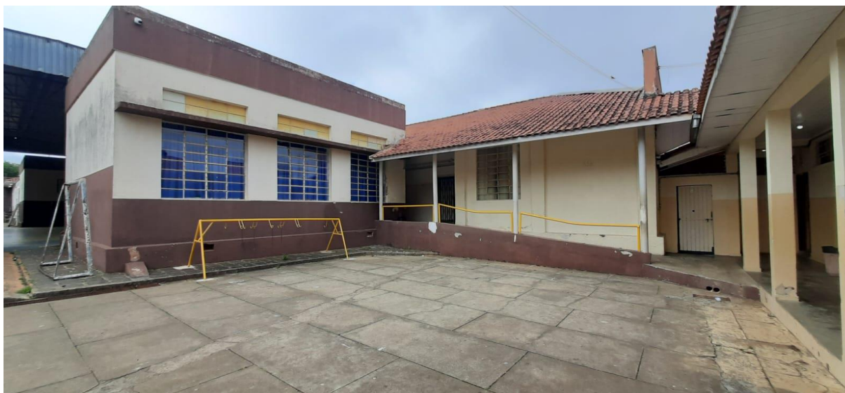
Figura 30 - Rampa principal 2 existente
