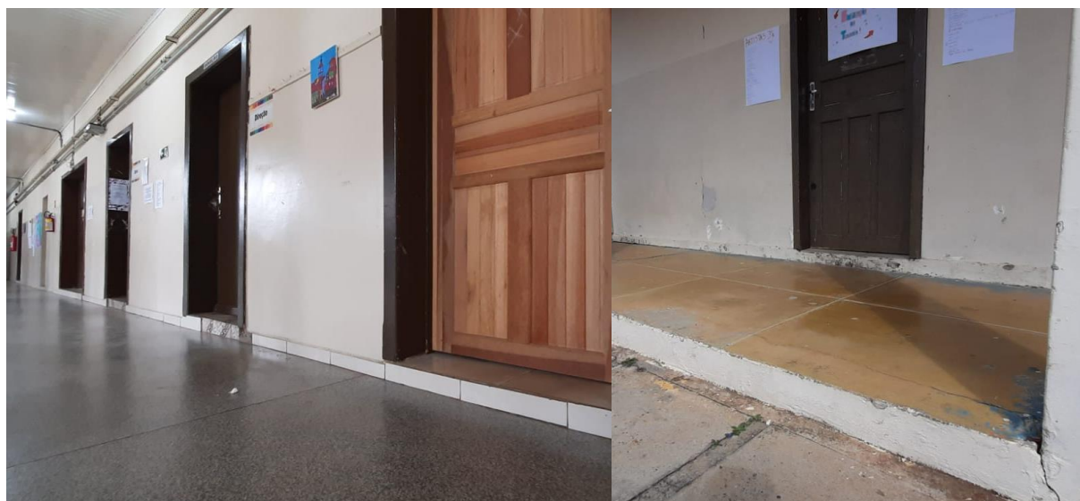
Figura 20 - Degraus para acesso dos ambientes nos blocos de aulas 1, 2 e 3, respectivamente
