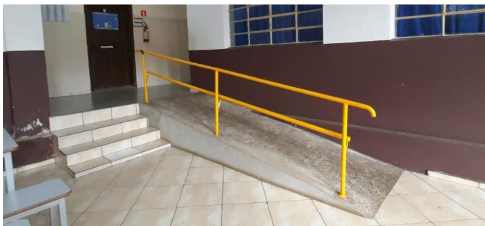
Figura 42 - Rampa principal 6 existente
