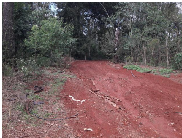
Figura 28 – Condições de via de transporte de estudantes, doentes e cargas no período de chuvas — Dom Tomás Balduino, Quedas do Iguaçu (PR), 2022
