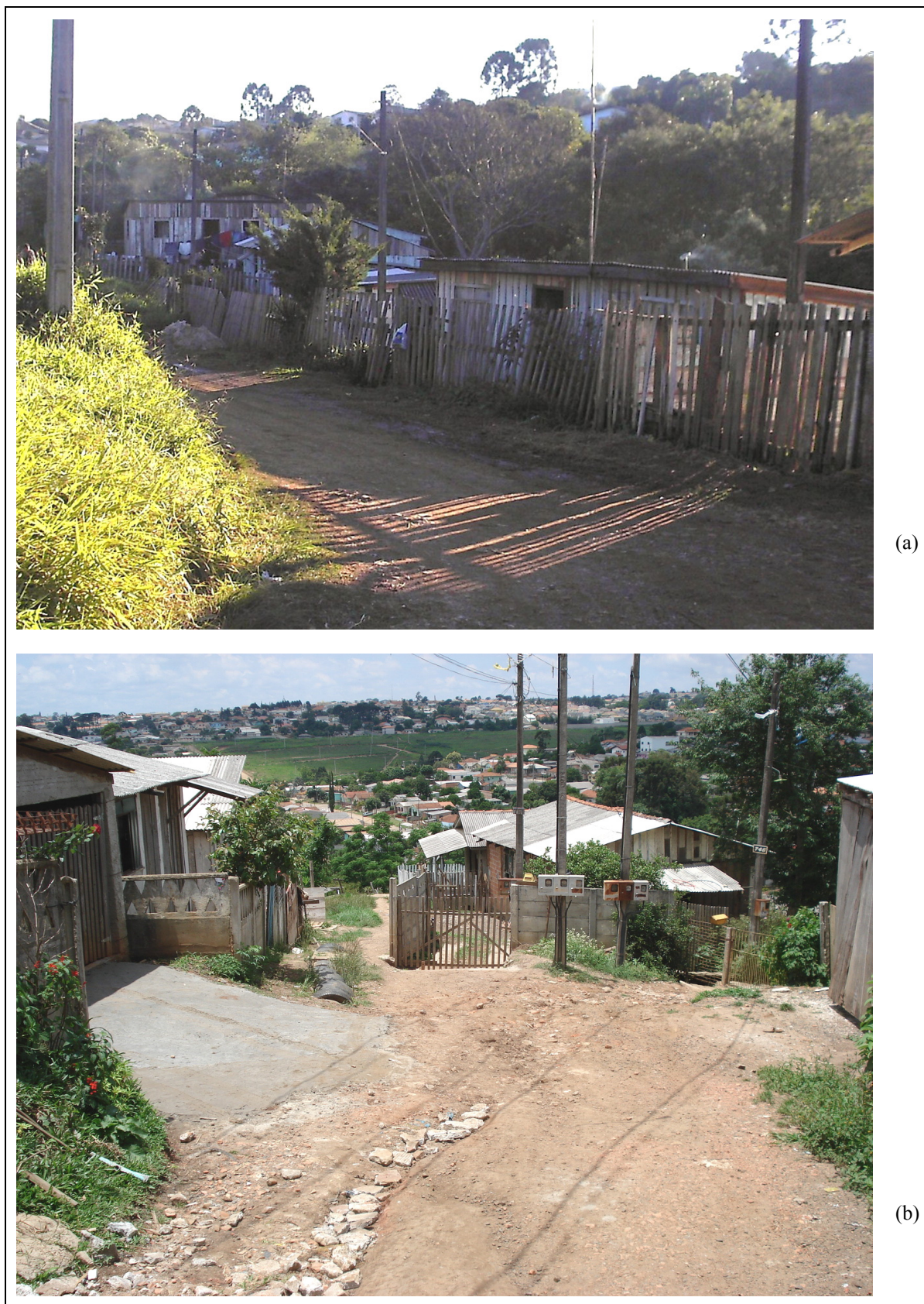
Figura 16 – Vista parcial de duas favelas em situação de média-alta exclusão social: a) vila Bonsucesso (Chapada); b) Parque Nossa Senhora das Graças (Boa Vista). Fotos: NASCIMENTO, E. (2007).
