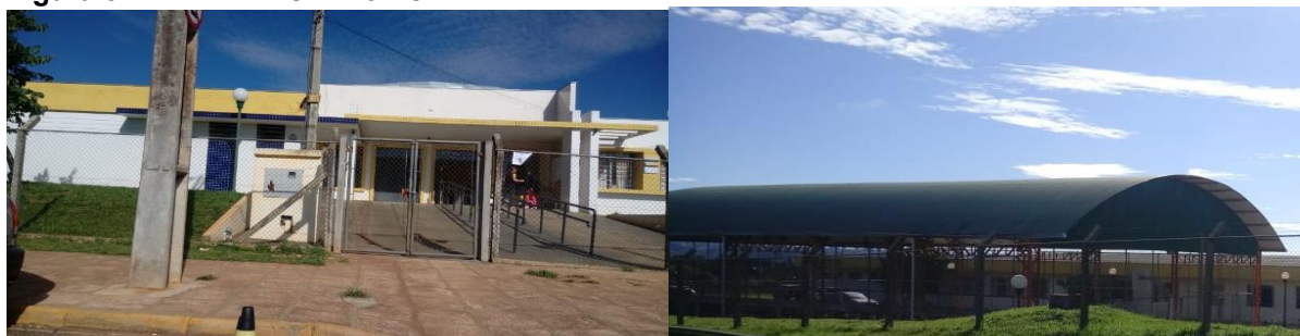
Figura 5 Estrutura CEEBJA CEEZ.
