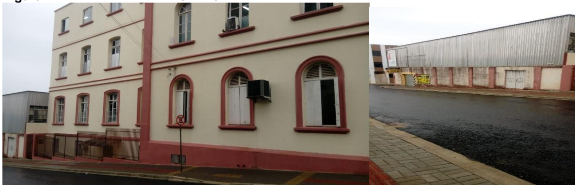
Figura 4 Estrutura exterior- CEEBJA PSR.
