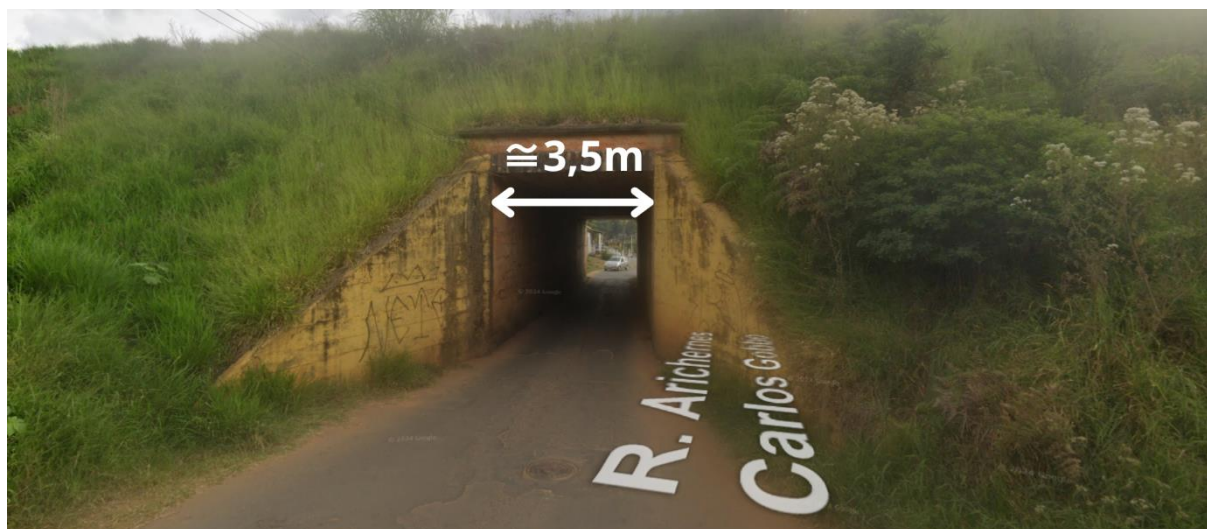
Figura 22 - Trincheira de entrada ao loteamento San Martin acessando pela rotatória da rua Rio verde
