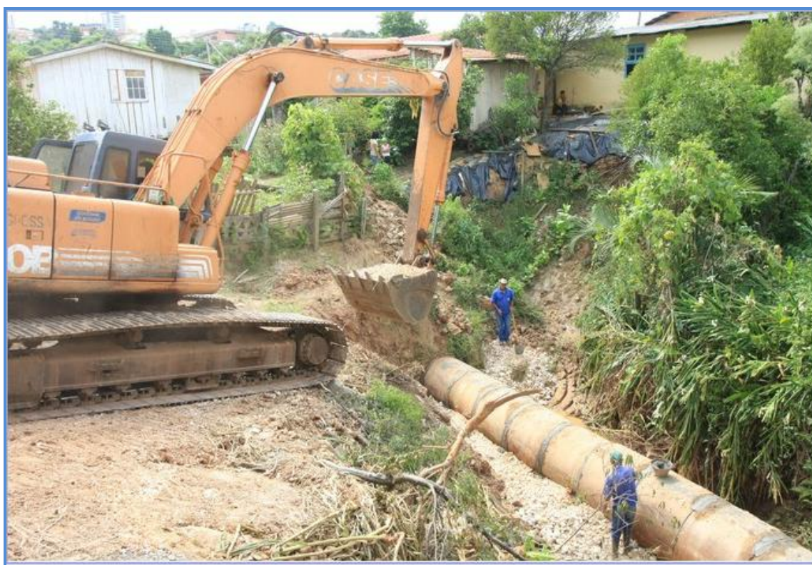
Figura 02 – Canalização de trecho do Arroio Olarias pela Prefeitura Municipal Fonte: Diário dos Campos, 10/03/2009 ano 102, nº 30.672 p. A2
