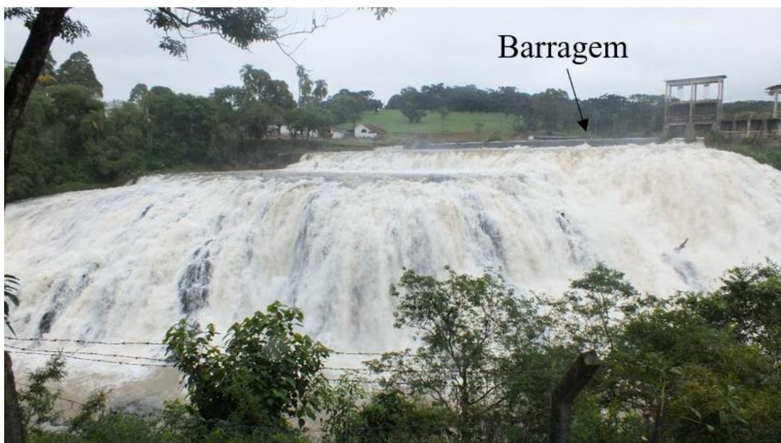
Figura 78 - Salto Manduri, com Pequena Central Hidrelétrica (PCH) ao fundo.
