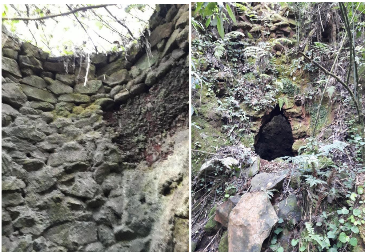
Imagem 2: Forno de barranco desativado, imagem interna Imagem 3: Forno de barranco desativado, imagem externa
