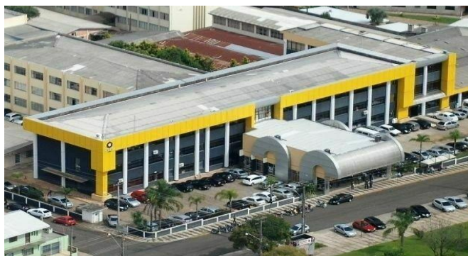
Figura 6 - Universidade Estadual do Centro-Oeste (Unicentro)- Campus Guarapuava
