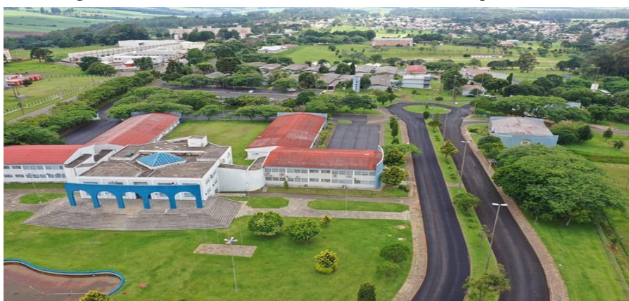
Figura 4: Universidade Estadual de Ponta Grossa - Campus Uvaranas
