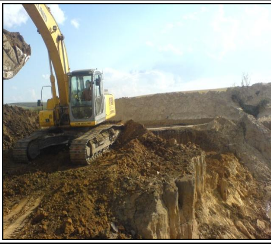
Figura 11: Processo de mitigação dos impactos, aterramento parcial da área NE da cava 6. Autor: Melo, 2009.
