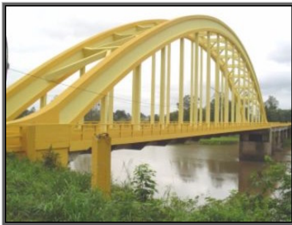
Foto 2: Ponte Manoel Ribas
