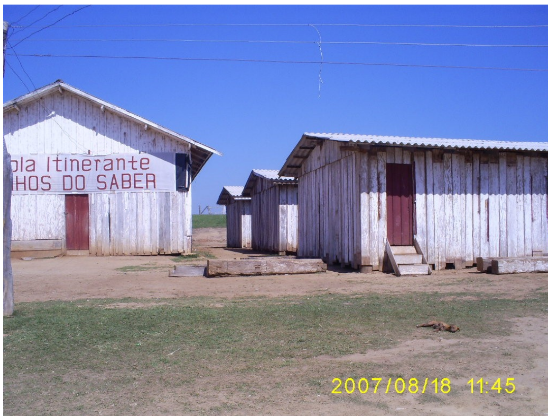
FOTOS 35 e 36: Estrutura física da Escola Itinerante Caminhos do Saber. Nessa fotografia à esquerda aparece a secretaria da Escola e salas de aula, com o campo de bola onde as crianças fazem atividades esportivas e recreativas. Na foto à direita aparece a Secretaria da Escola vista de frente onde tem a faixa com o nome, e três salas de aula. Cada construção dessas é uma sala de aula. Essa estrutura já existia na Fazenda. Foi reformada pelos Sem Terra com ajuda de recursos do Estado. Essa foto foi tirada do pátio em frente à Escola. Fonte: Arquivo de pesquisa, 2007.
