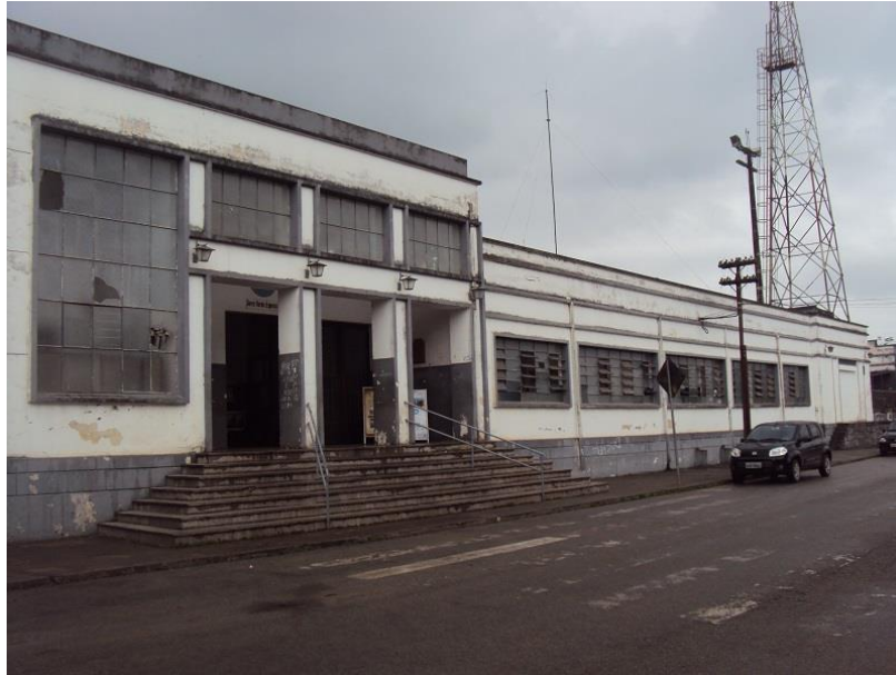
FOTOGRAFIA 09 - ESTAÇÃO DE MORRETES: FACHADA PRINCIPAL
