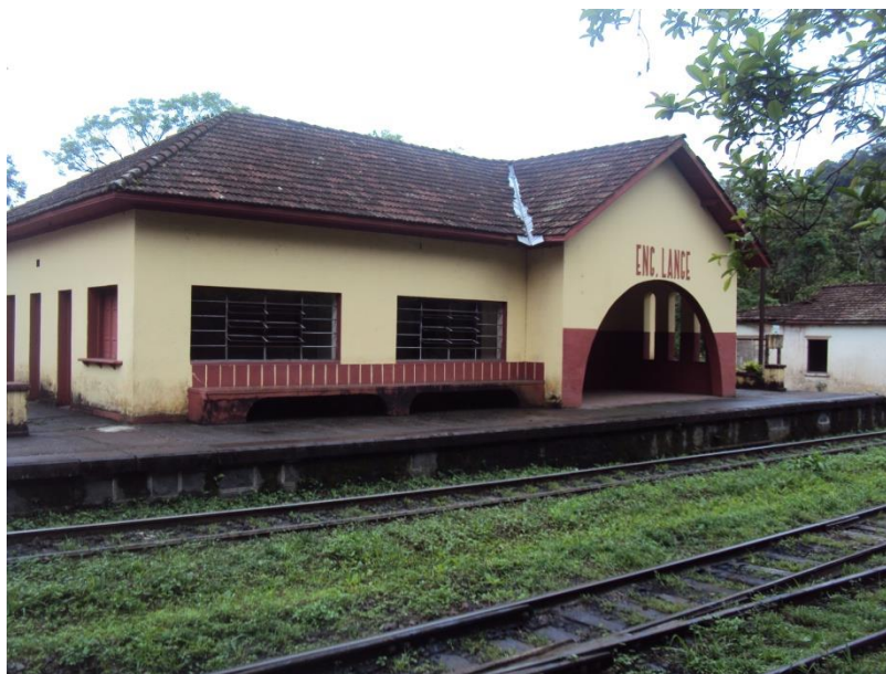
FOTOGRAFIA 18 - ESTAÇÃO ENGENHEIRO LANGE
