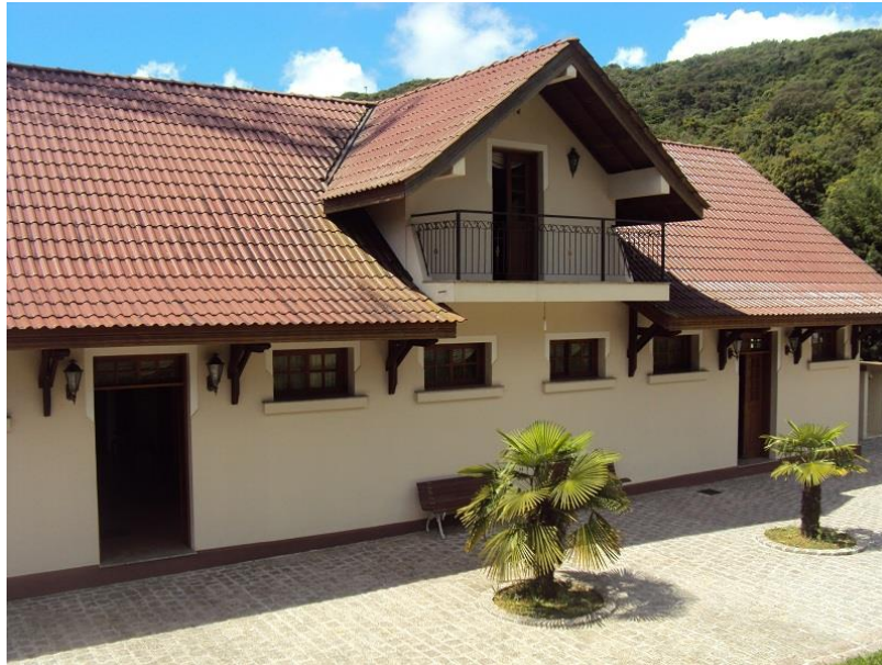
FOTOGRAFIA 28 - ESTAÇÃO DE ROÇA NOVA II
