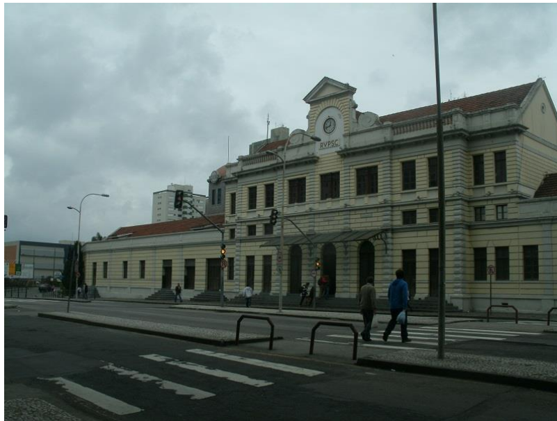
FOTOGRAFIA 41 - FACHADA PRINCIPAL DA ESTAÇÃO DE CURITIBA
