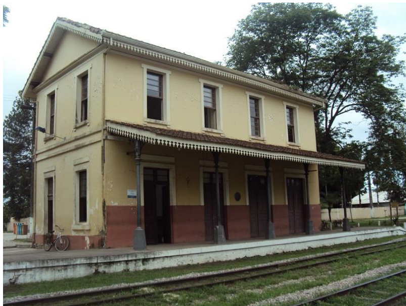
FOTOGRAFIA 08 - ESTAÇÃO DE ALEXANDRA: ÁREA DA PLATAFORMA II
