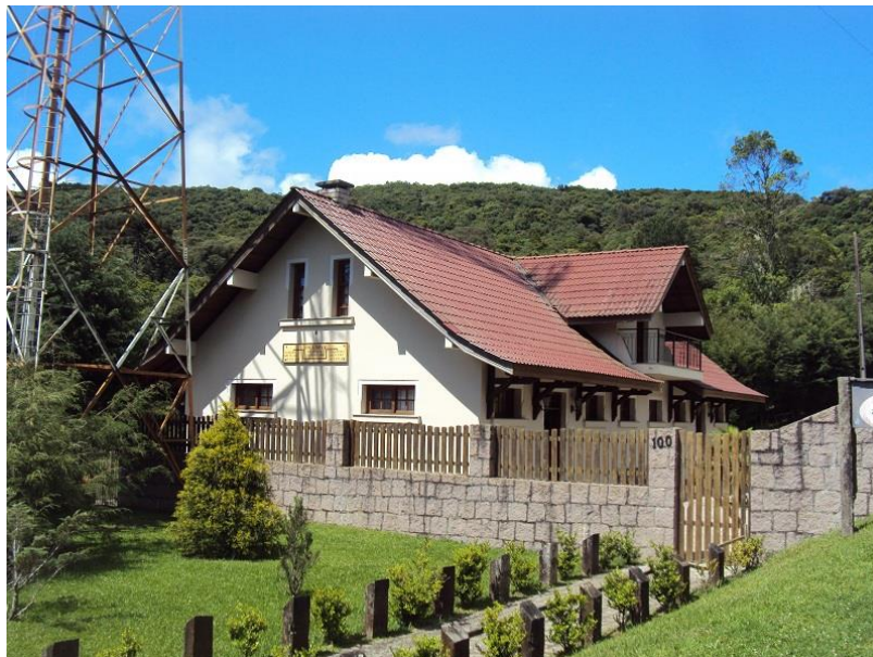
FOTOGRAFIA 29 - ESTAÇÃO DE ROÇA NOVA III
