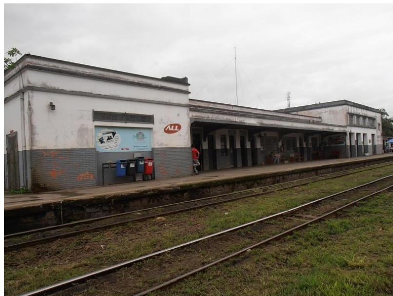
FOTOGRAFIA 10 - ESTAÇÃO DE MORRETES: ÁREA DA PLATAFORMA
