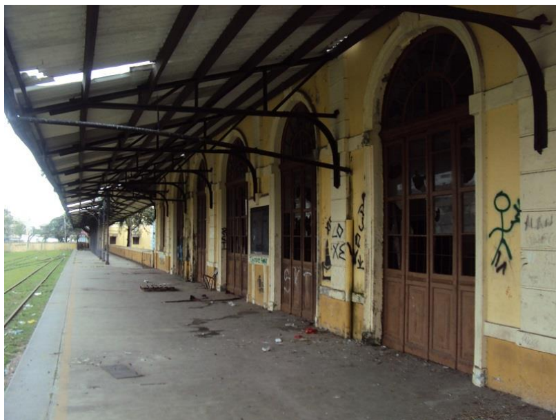
FOTOGRAFIA 03 - ESTAÇÃO DE PARANAGUÁ: ÁREA DA PLATAFORMA II
