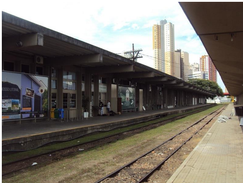
FOTOGRAFIA 39 - PLATAFORMA DA ESTAÇÃO DE CURITIBA (NOVA) II
