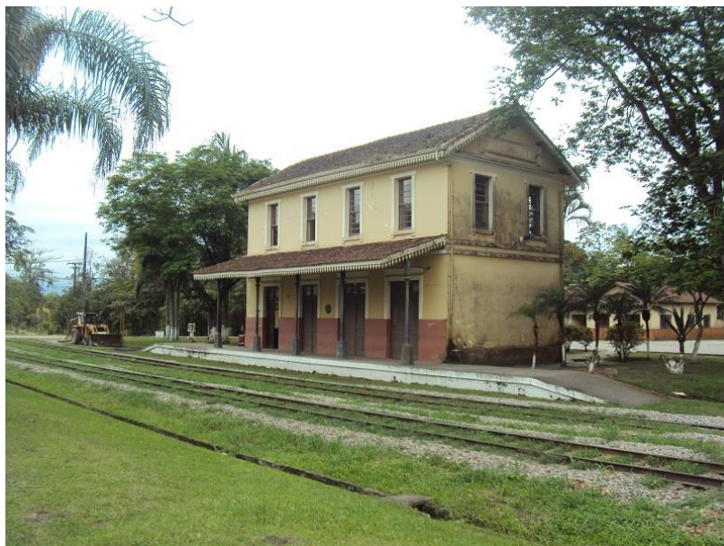
FOTOGRAFIA 07 - ESTAÇÃO DE ALEXANDRA: ÁREA DA PLATAFORMA I
