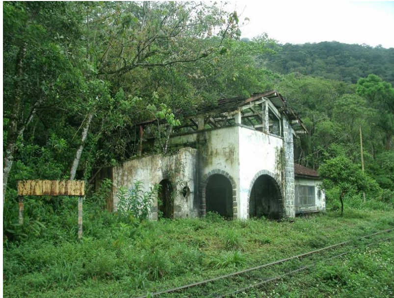
FOTOGRAFIA 17 - ESTAÇÃO PORTO DE CIMA II
