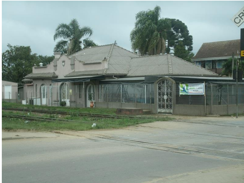
FOTOGRAFIA 31 - ESTAÇÃO DE PIRAQUARA I
