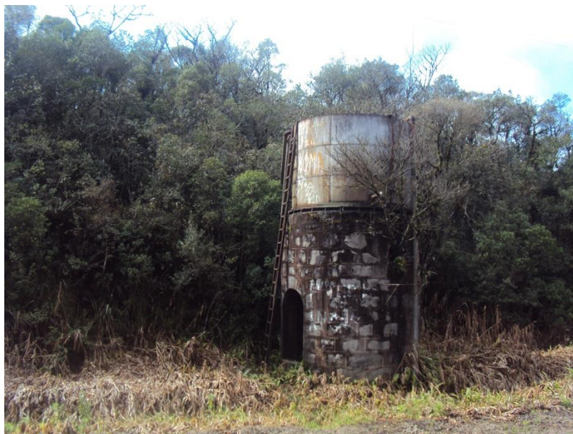
FOTOGRAFIA 43 – CAIXA D'ÁGUA NO ENTORNO DA ESTAÇÃO DE BANHADO
