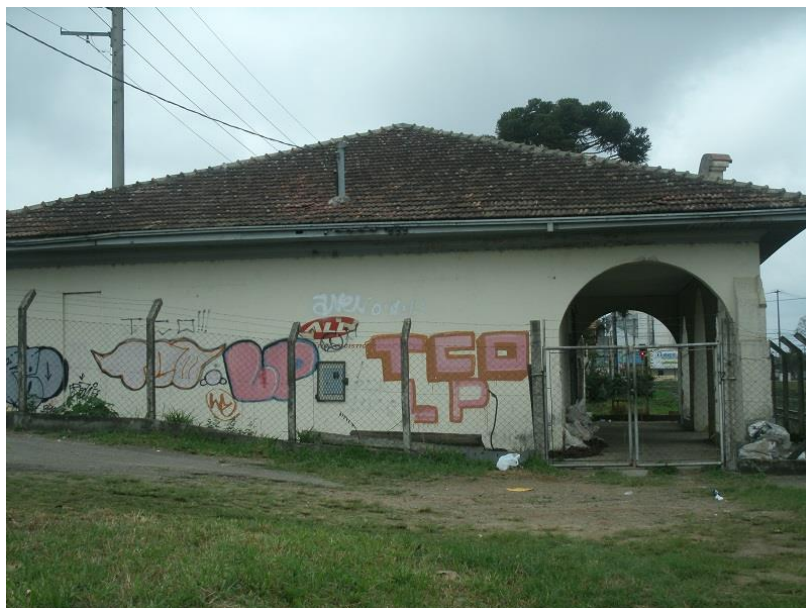
FOTOGRAFIA 36 - LATERAL DA ESTAÇÃO DE PINHAIS
