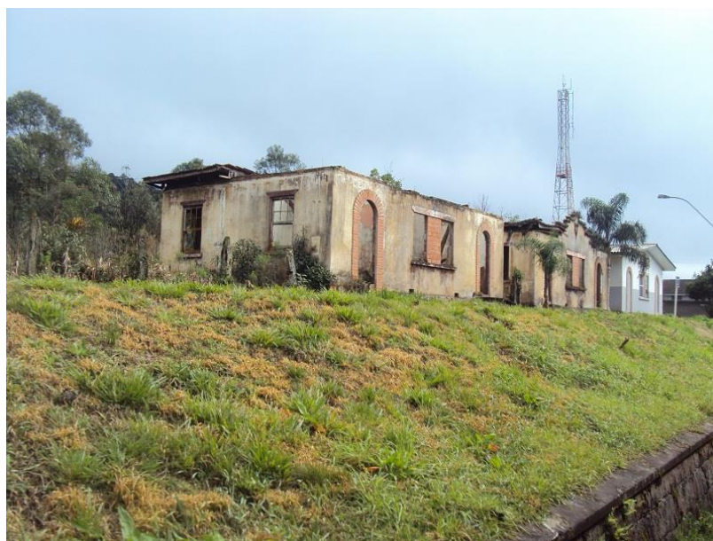
FOTOGRAFIA 26 – RESIDÊNCIAS NO ENTORNO DA ESTAÇÃO DE BANHADO
