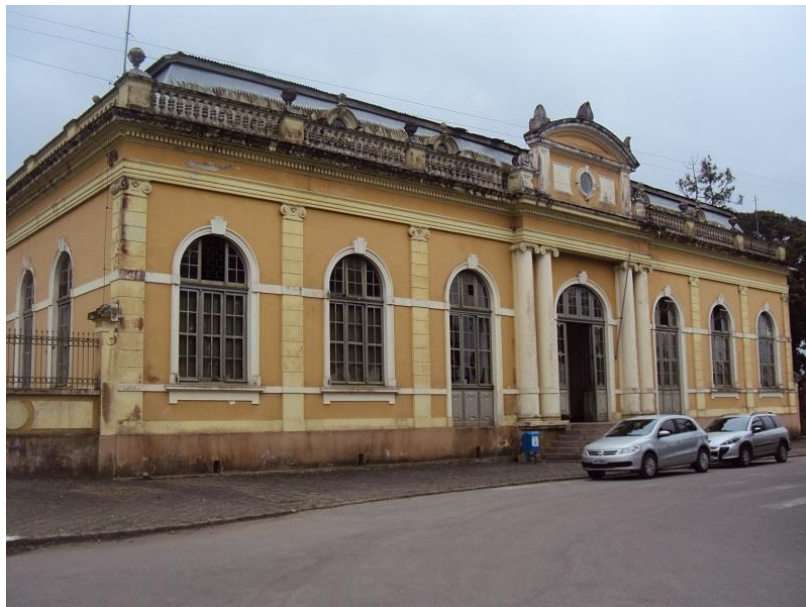
FOTOGRAFIA 13 - ESTAÇÃO DE ANTONINA: FACHADA PRINCIPAL
