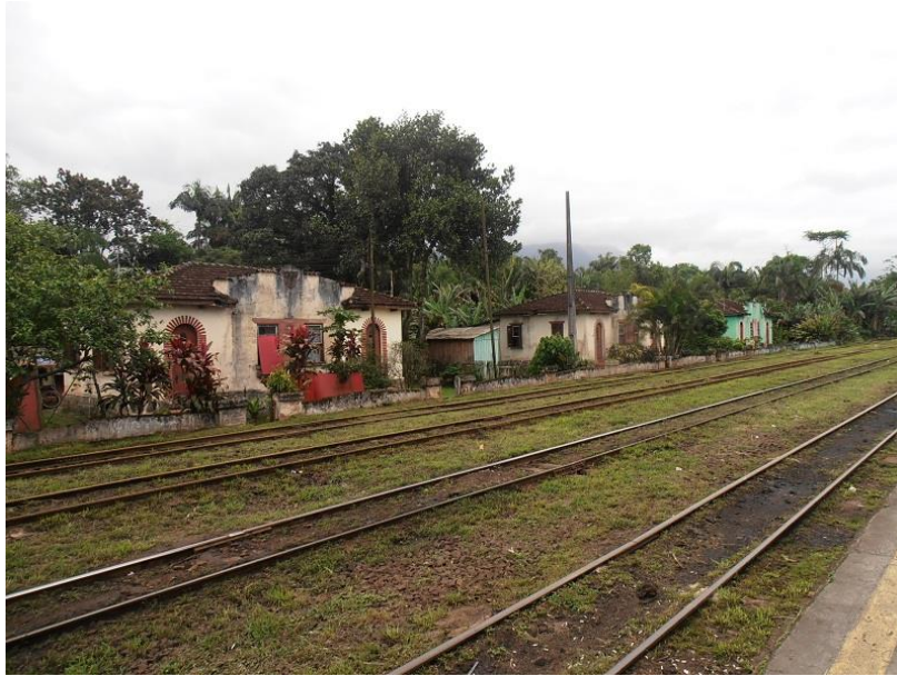
FOTOGRAFIA 11 – RESIDÊNCIAS NO ENTORNO DA ESTAÇÃO DE MORRETES
