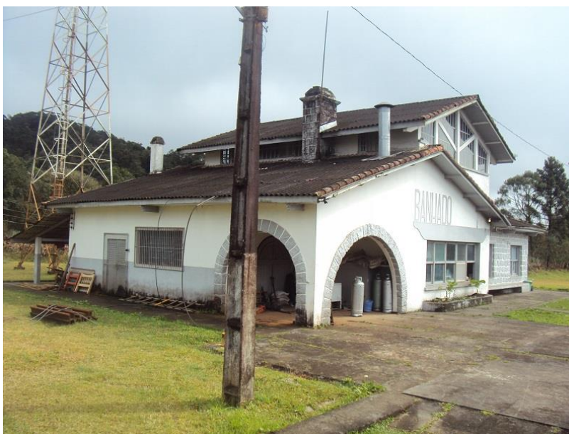
FOTOGRAFIA 24 - ESTAÇÃO DE BANHADO I
