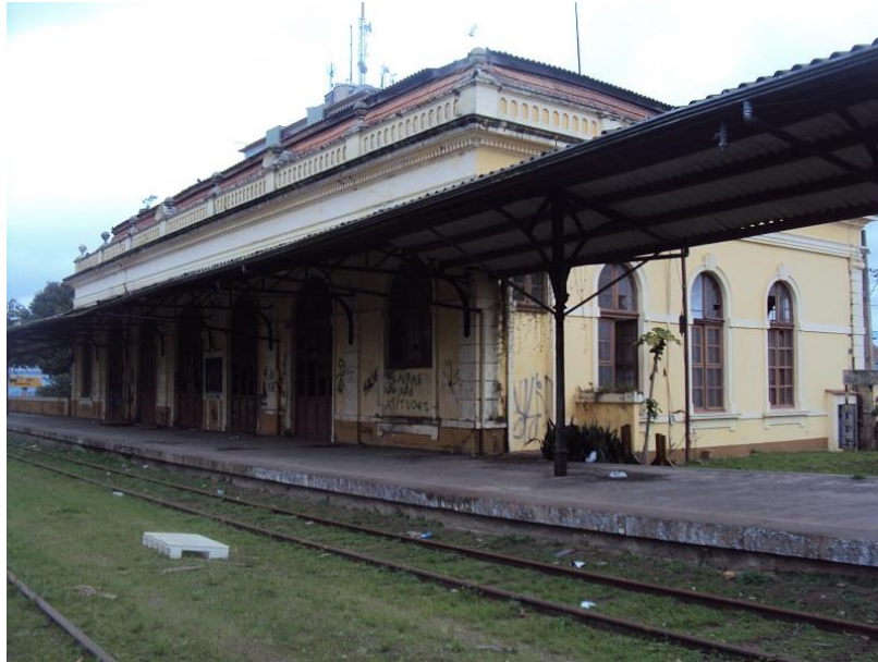
FOTOGRAFIA 02 - ESTAÇÃO DE PARANAGUÁ: ÁREA DA PLATAFORMA I
