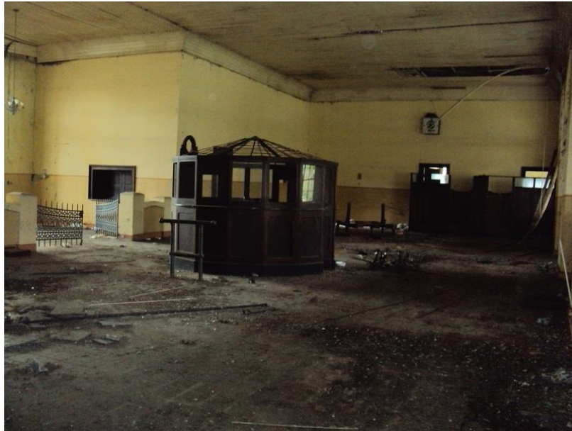
FOTOGRAFIA 04 – INTERIOR DA ESTAÇÃO DE PARANAGUÁ
