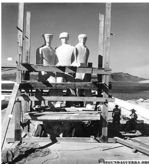
FOTOGRAFIA 1 – Construção do Monumento aos Mortos da FEB (RJ), 1963.
