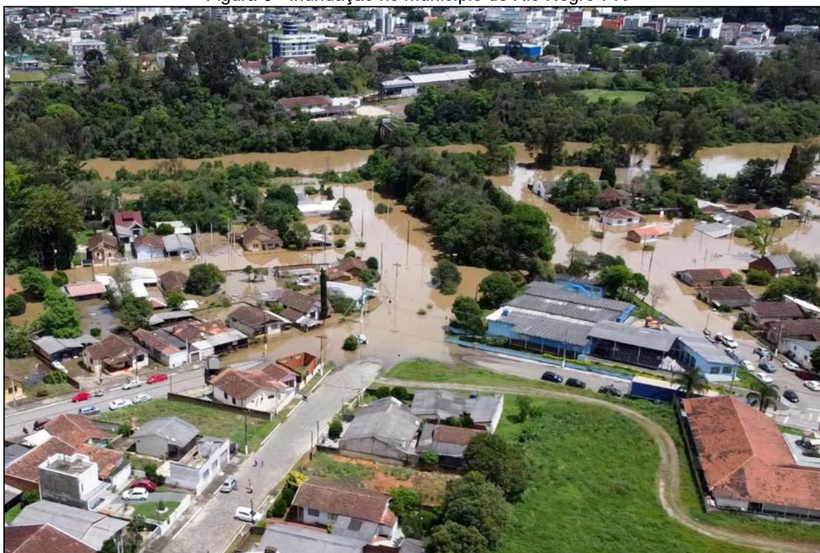
Figura 6 - Inundação no município de Rio Negro-PR
