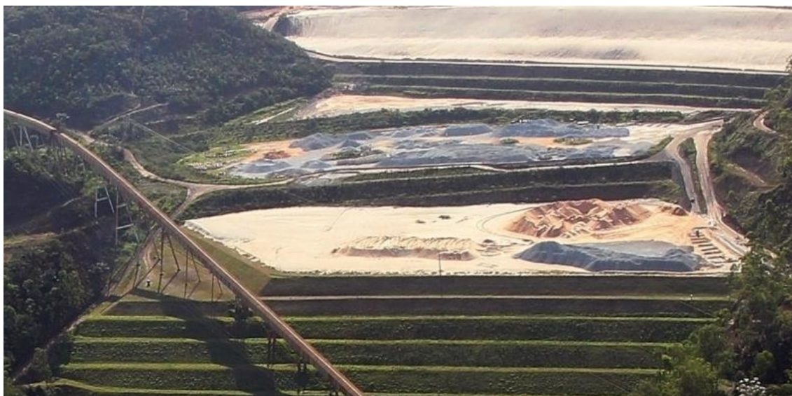
Fotografia 7: Barragem construída ou alteada pelo método a montante
