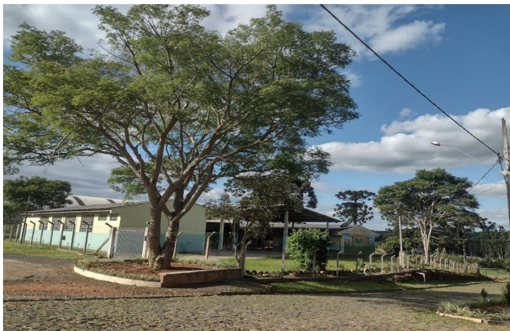
Figura 4 – Vista lateral da Escola Municipal do Campo São Sebastião
