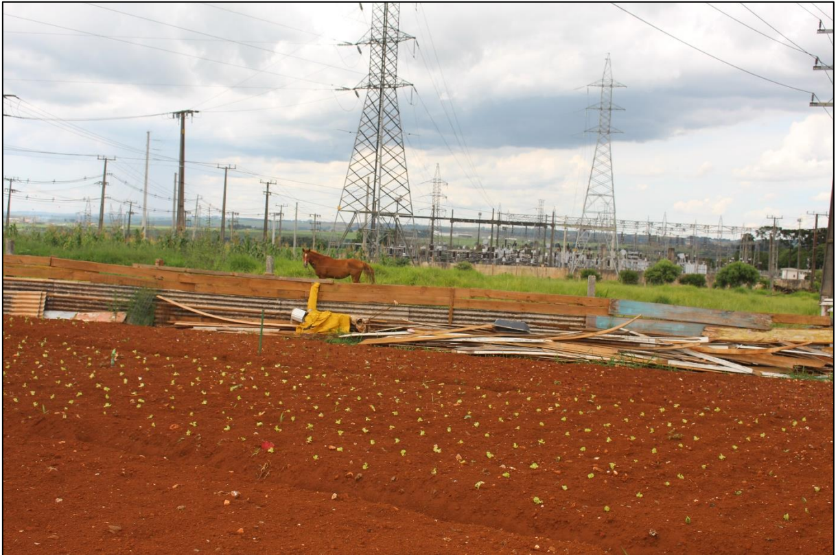
FIGURA 2 – Torres de energia elétrica dividindo espaço com simbolismos rurais na vila Santa Mônica.
