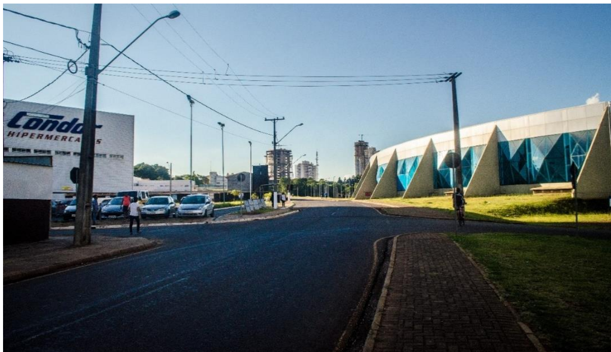
Figura 108 – Arena multiuso implantada no canteiro da Avenida dos Vereadores e supermercado construído em frente.
