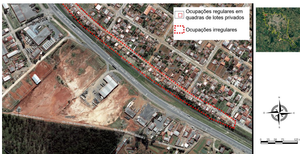
Figura 34 – Ocupações irregulares próximas à ferrovia que contorna a cidade, no bairro Chapada.
