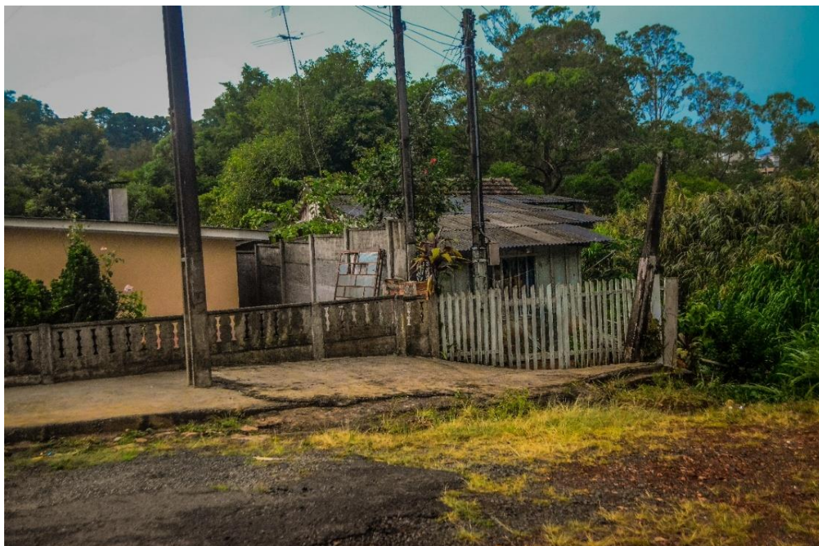
Figura 100 – Final da Rua Nestor de Castro e a ocupação irregular isolada, próxima ao curso d'água, no fundo da imagem.
