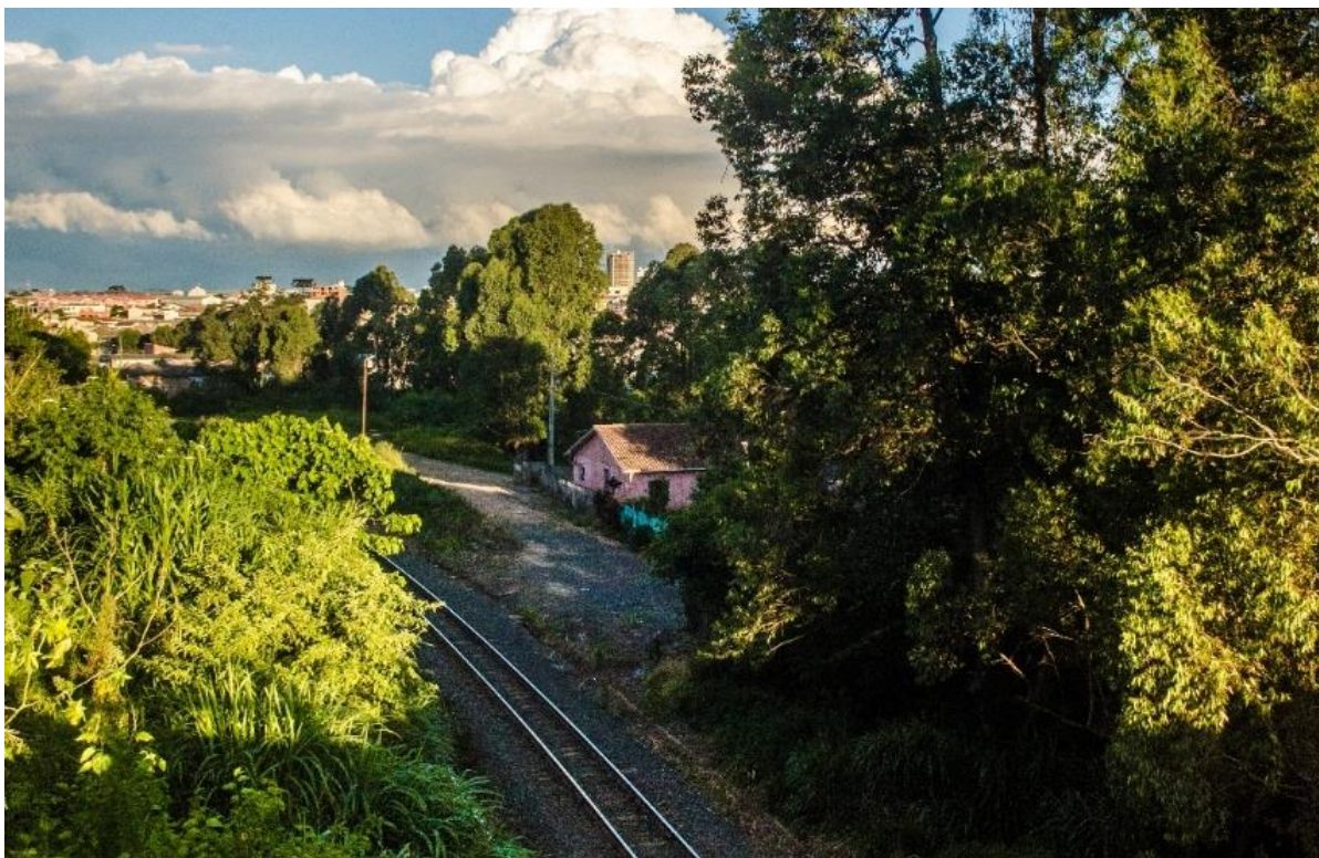
Figura 32 – Residência em local irregular, na faixa de domínio da ferrovia, logo após o cruzamento em nível com a Rodovia BR-376.
