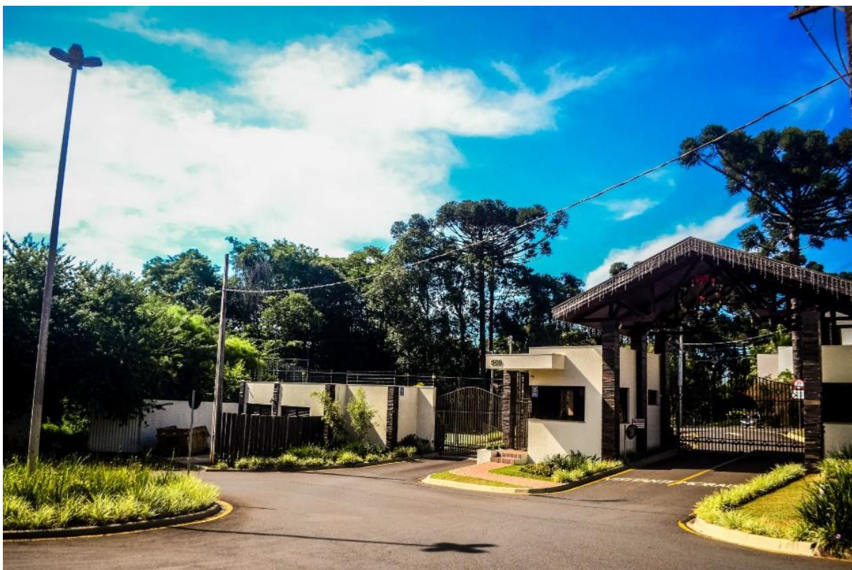
Figura 90 – Portão de acesso ao Condomínio Spazio Verde.
