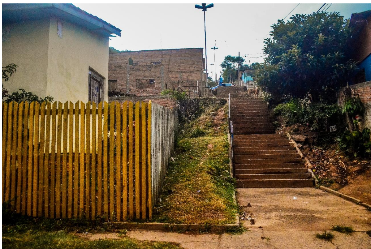
Figura 79 – Escadaria na ocupação irregular Vila Nova, no bairro Estrela.
