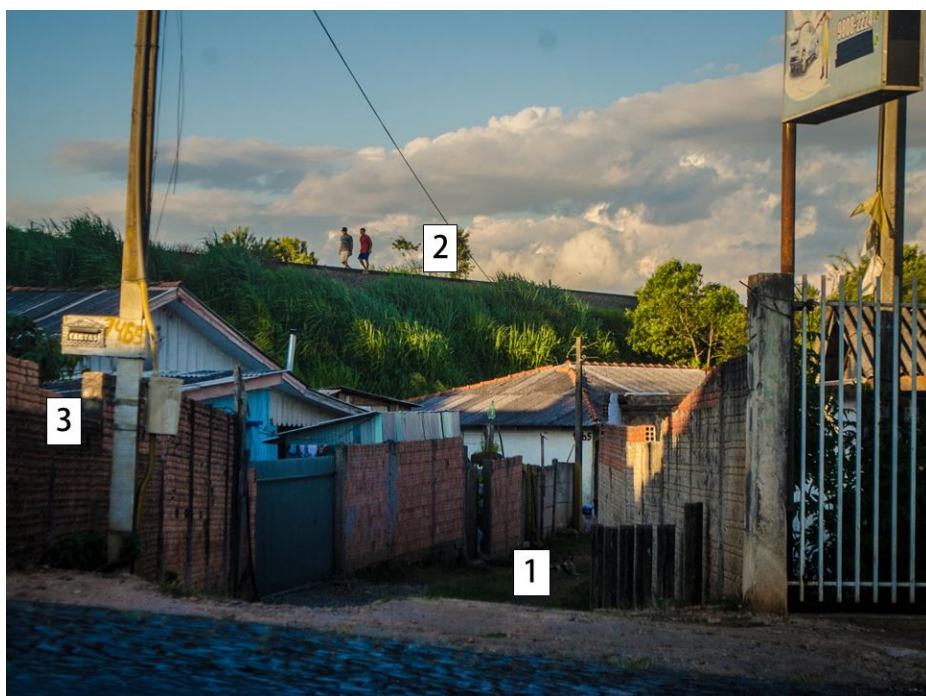
Figura 30 – Ocupações irregulares na faixa de domínio da linha férrea.
