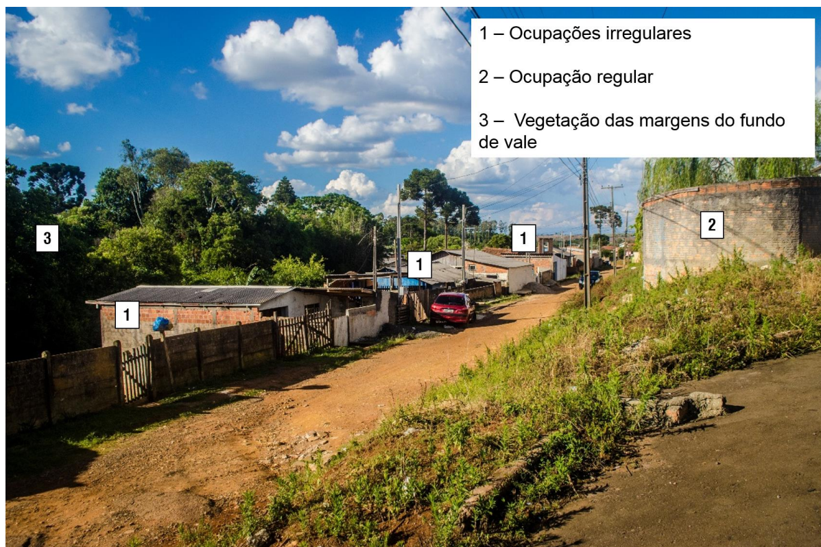
Figura 27 – Ocupação Irregular da Rua Enfermeira Adelaide Pareta, às margens de um curso d'água.
