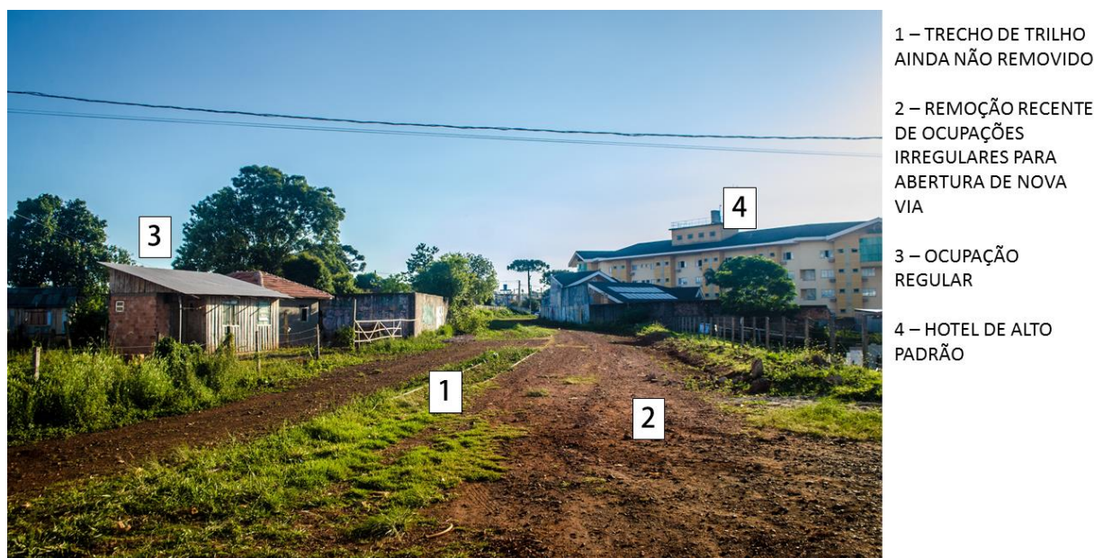
Figura 36 – Residência em local irregular, na faixa de domínio da ferrovia.
