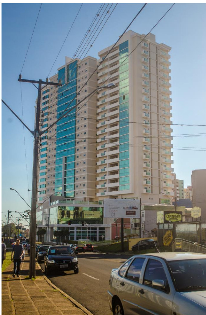
Figura 106 – Edifício de grande porte ao longo da antiga linha férrea.
