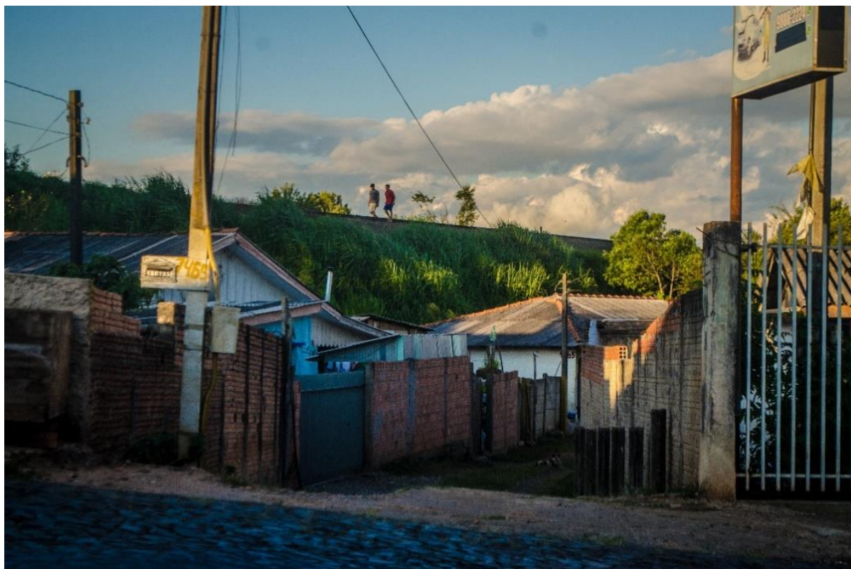
Figura 69 – Beco de trânsito de pedestres para acesso às residências da comunidade da Rua Custódio Vaz.
