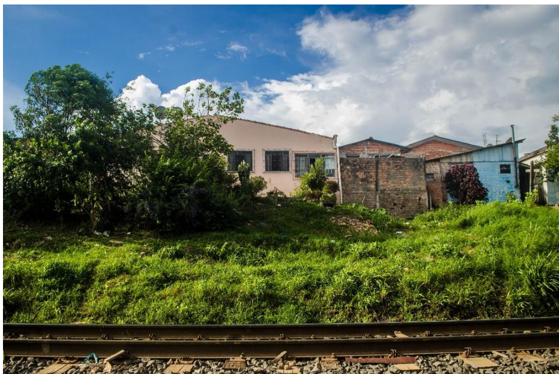
Figura 67 – A comunidade da Rua Custódio Vaz, com residências acessadas através da faixa de domínio da ferrovia.
