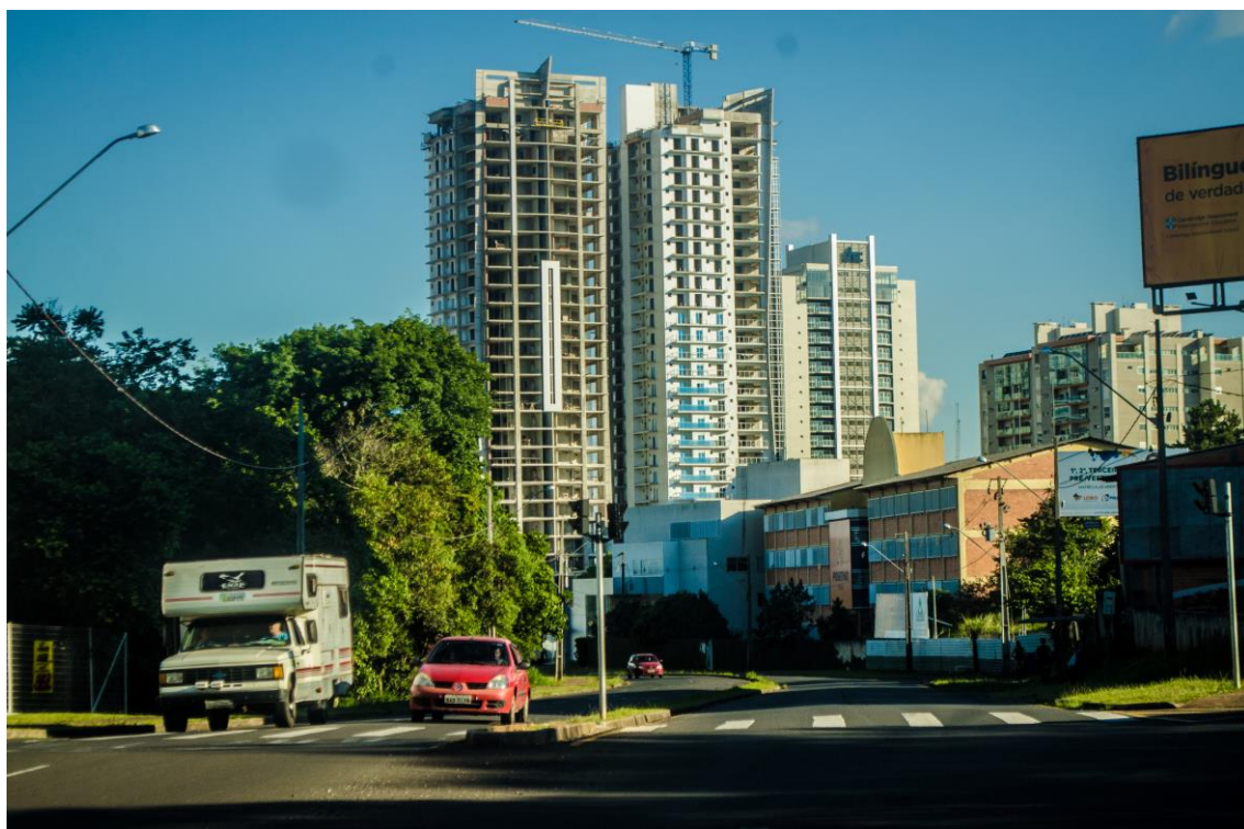
Figura 14– Edifícios de luxo de grande porte, localizados nas proximidades da Av. dos Vereadores, antiga ferrovia.
