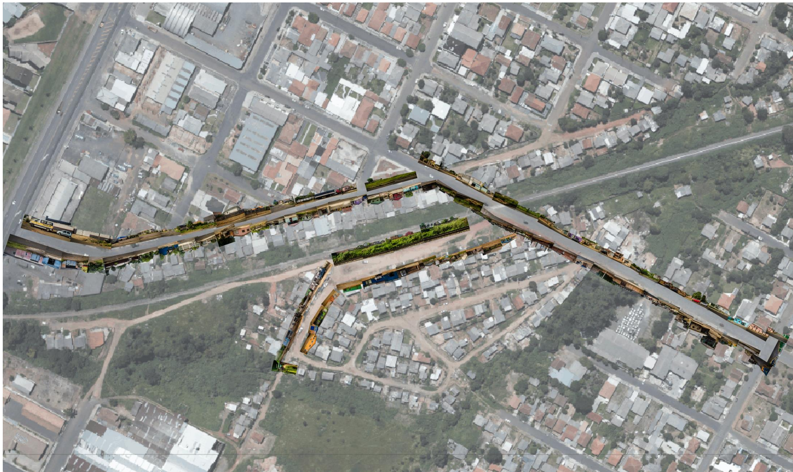
Figura 64 – Edificações ao longo da área delimitada para o “Estudo de Caso 01 – Campo do Fubá”.
